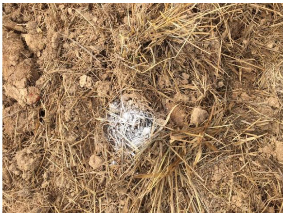
Figura 14: Cal virgem utilizada para sinalizar a marcação.
