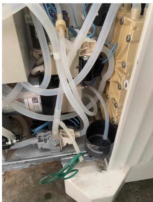
Figura 25 - Impedimento de vazamento e recipiente
