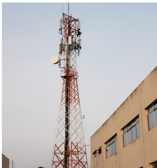
Figura 3.6 – Torre da empresa Algar Telecom.
