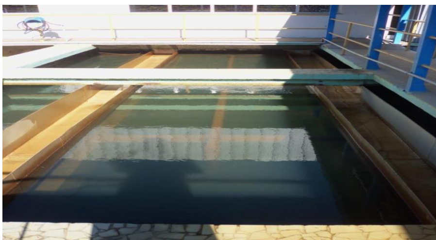
Figura 9 – Filtro em concreto armado.
