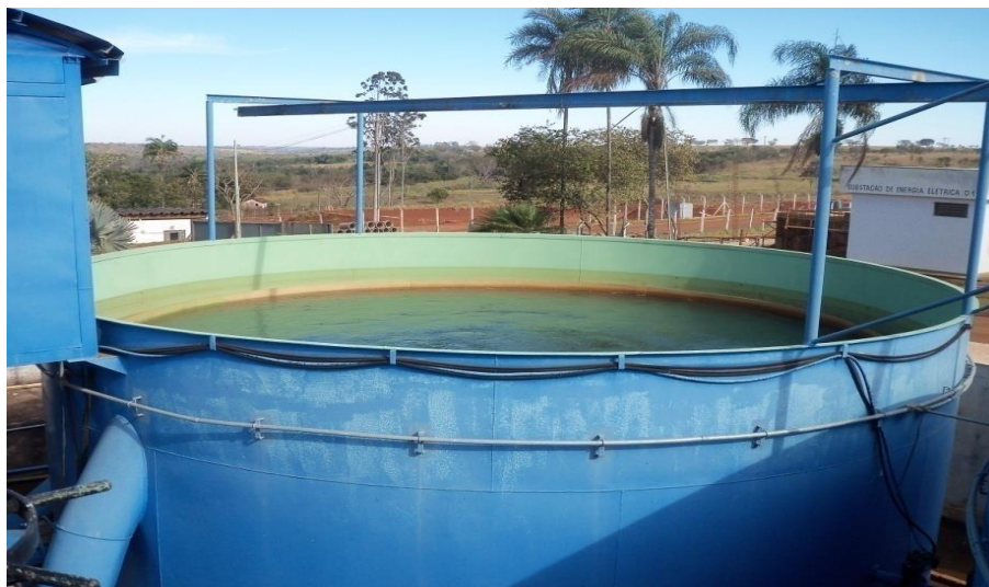
Figura 10 – Filtro de aço.
