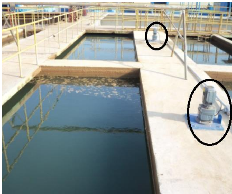
Figura 6 – Flocluladores Mecanizados
