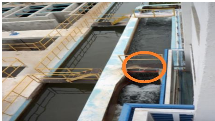
Figura 5 – Calha Parshall.
