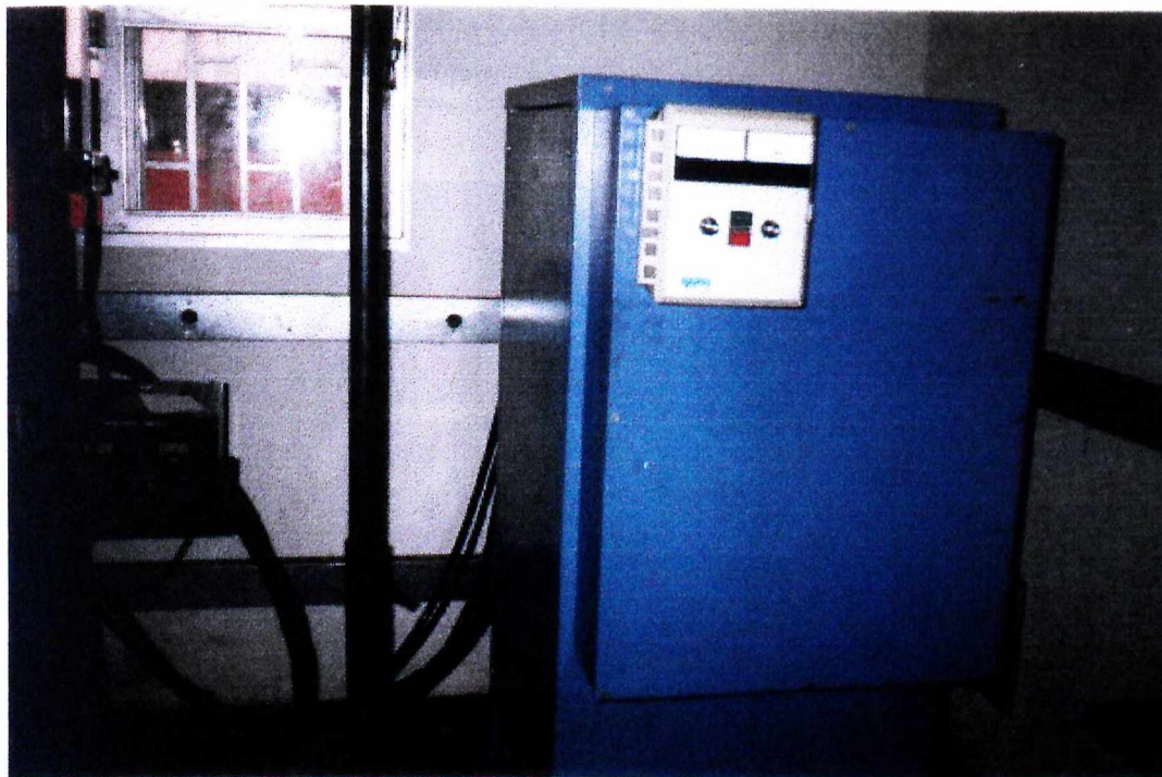
Figura 3.3 - Vista principal da fonte de potência incorporada à retificadora
