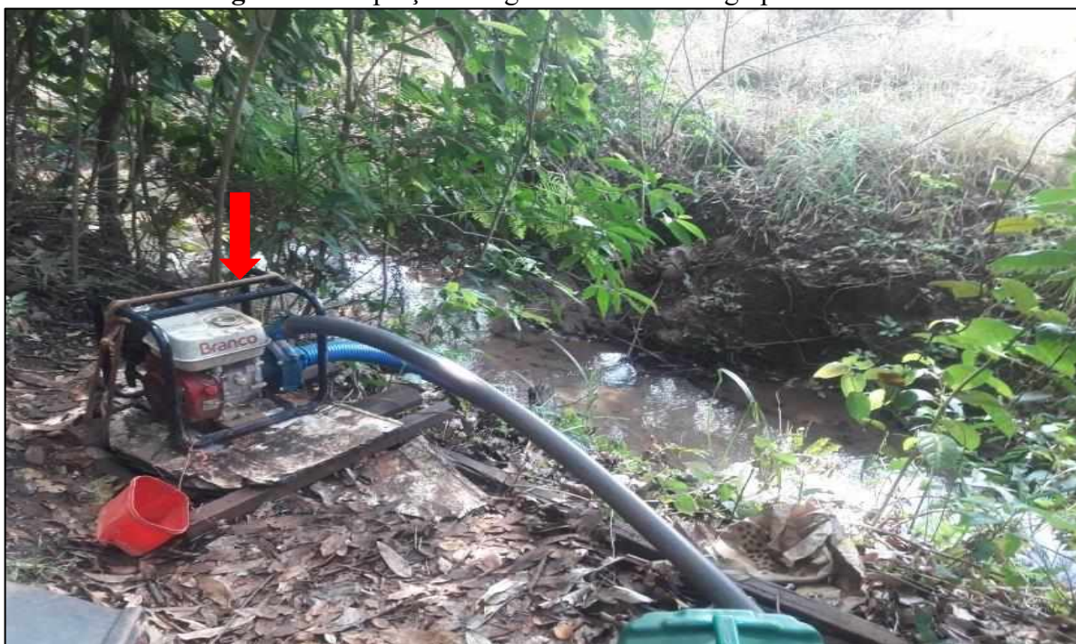
Figura 17: Captação de água direto do córrego por bomba
