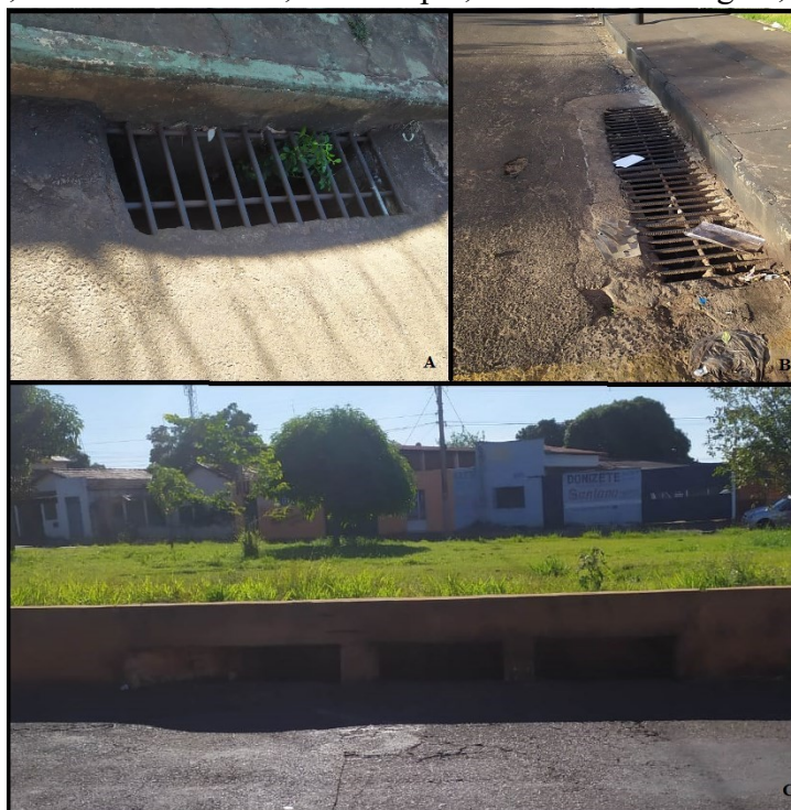
Figura 7: Tipos de bocas de lobo na Avenida Minas Gerais: A- com grade, com rebaixamento, B- com grade, sem rebaixamento, C- múltipla, com abertura na guia, sem depressão
