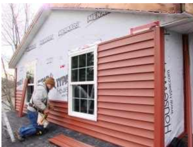
Figura 10: Aplicação de siding
