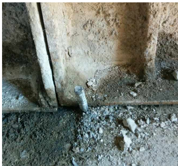
Figura 15: Base da forma travada
