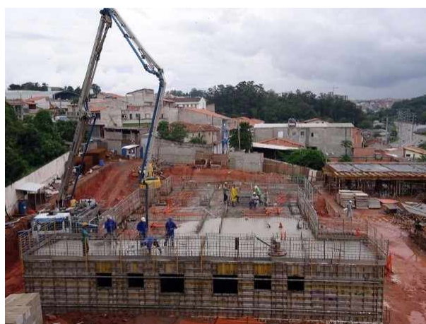
Figura 16: Lançamento do concreto
