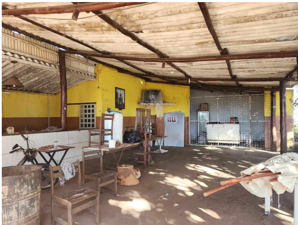
Figura 67 – Terrerão do Samba, vista da varanda.
