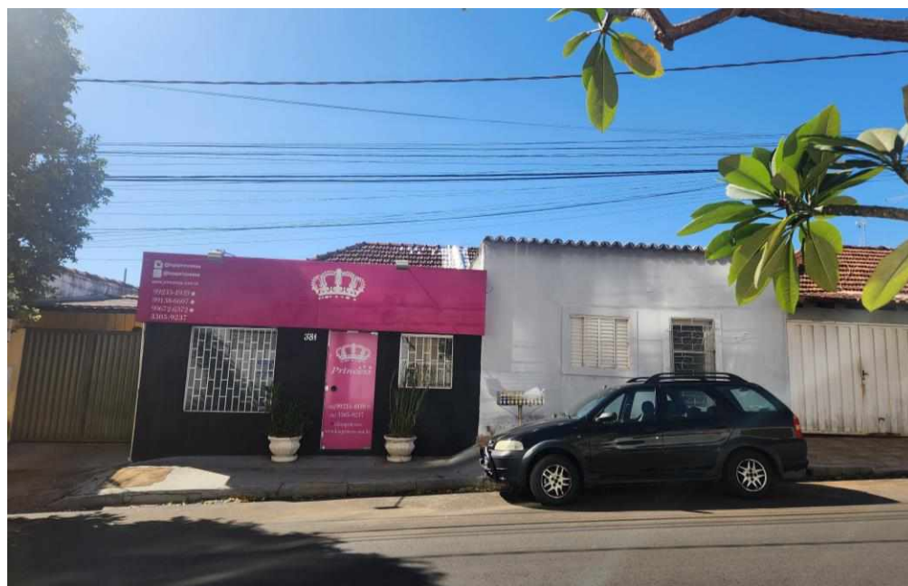
Figura 43 – Colônia dos Naves, Rua Ipanema, casas 1 e 2 (geminadas)
