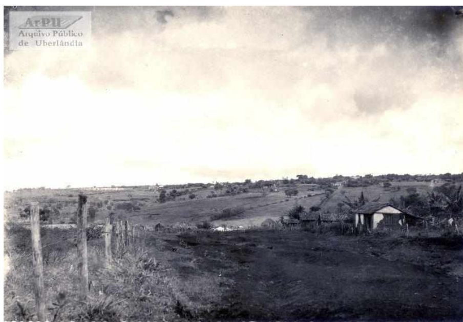
Figura 23 - Vista parcial da cidade. Em primeiro plano bairro Patrimônio. Segundo plano lado direito o atual bairro Fundinho e lado esquerdo bairro Tabajaras, mostrando o cemitério na atual Vila dos Militares. Rua General Osório em 2º plano. Década de 1920.
