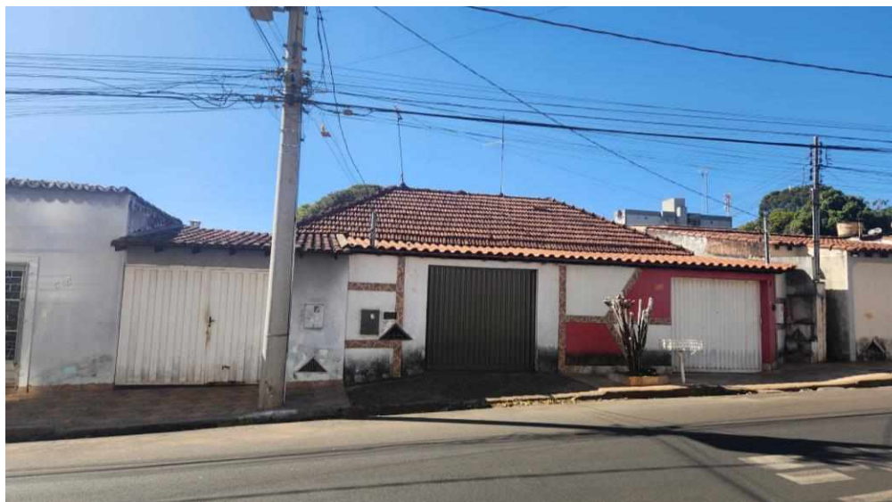
Figura 44 - Colônia dos Naves, Rua Ipanema, casas 3 e 4 (geminadas)
