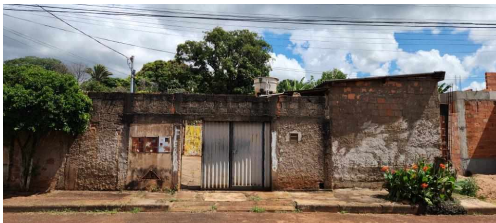
Figura 37 – Residência das irmãs Elza e Odete
