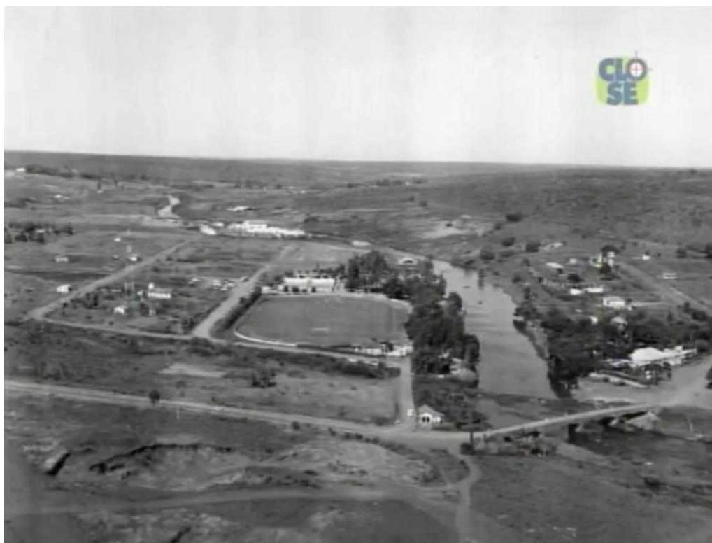
Figura 19 – Vista do Rio Uberabinha, com o Praia Clube e, ao fundo, o Frigorífico.
