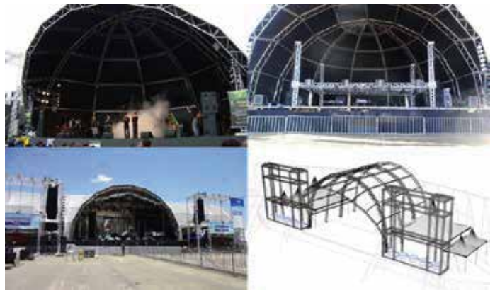
Figura 17: Estrutura Geospace (estrutura em alumínio que forma uma concha acústica) Fonte: http://novatenda.com.br/produtos/palco-geo-space/
