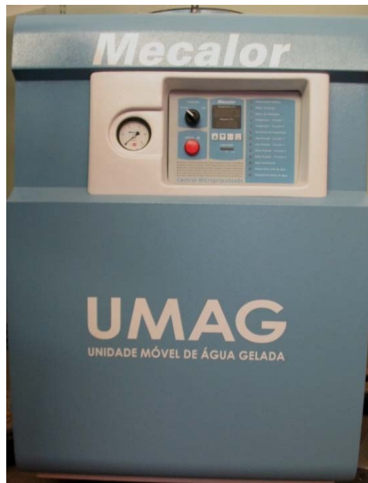
Figura A.8 – Sistema de refrigeração de água.
