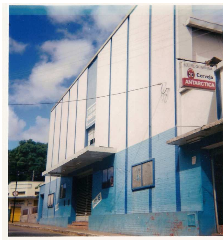
Figura 17 – Cine Cel. Ribeiro na década de 1980. Detalhe para a fachada retilínea do cinema e a praça Coronel urbanizada.
