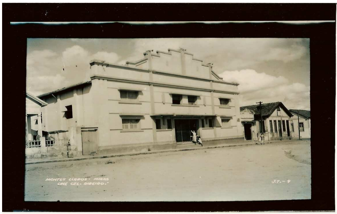
Figura 16 – Cine Cel. Ribeiro na década de 1950. Detalhe para os duas espectadoras e a praça Coronel sem urbanização. Fonte: DPDOR-UNIMONTES.
