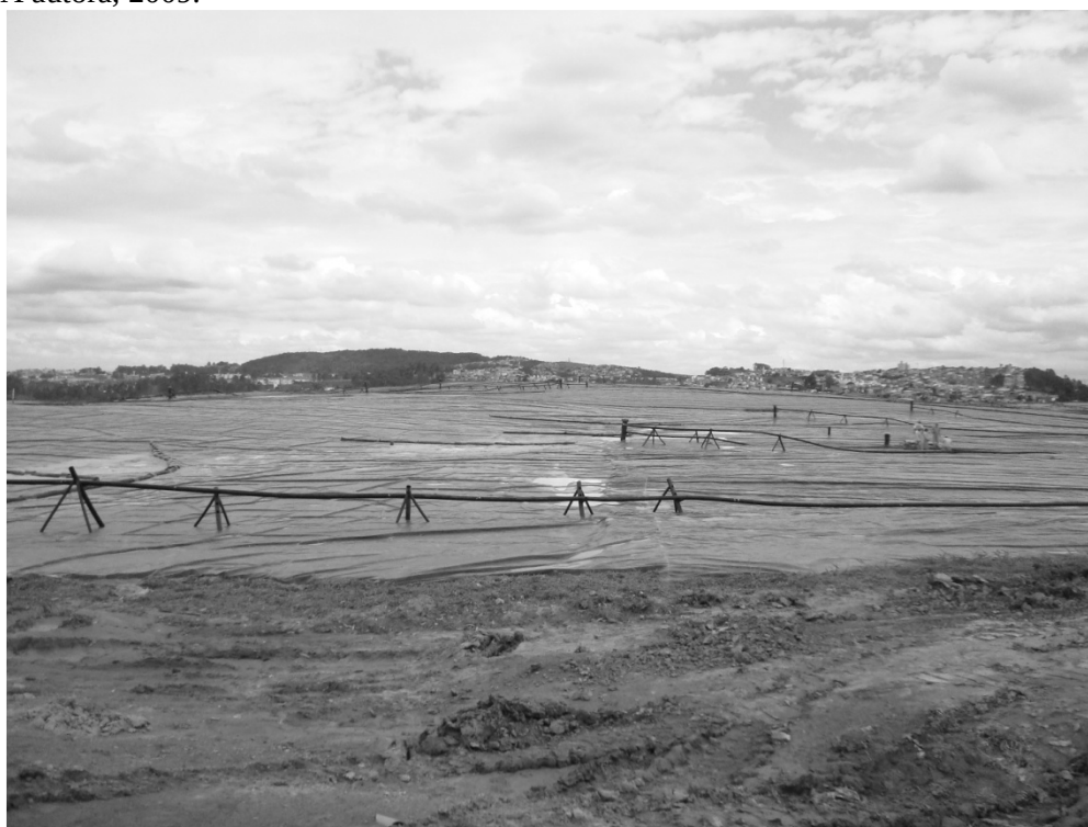
Figura 38: Cobertura com manta de PEAD nas áreas de captação de biogás, aterro Bandeirantes, São Paulo – SP.
