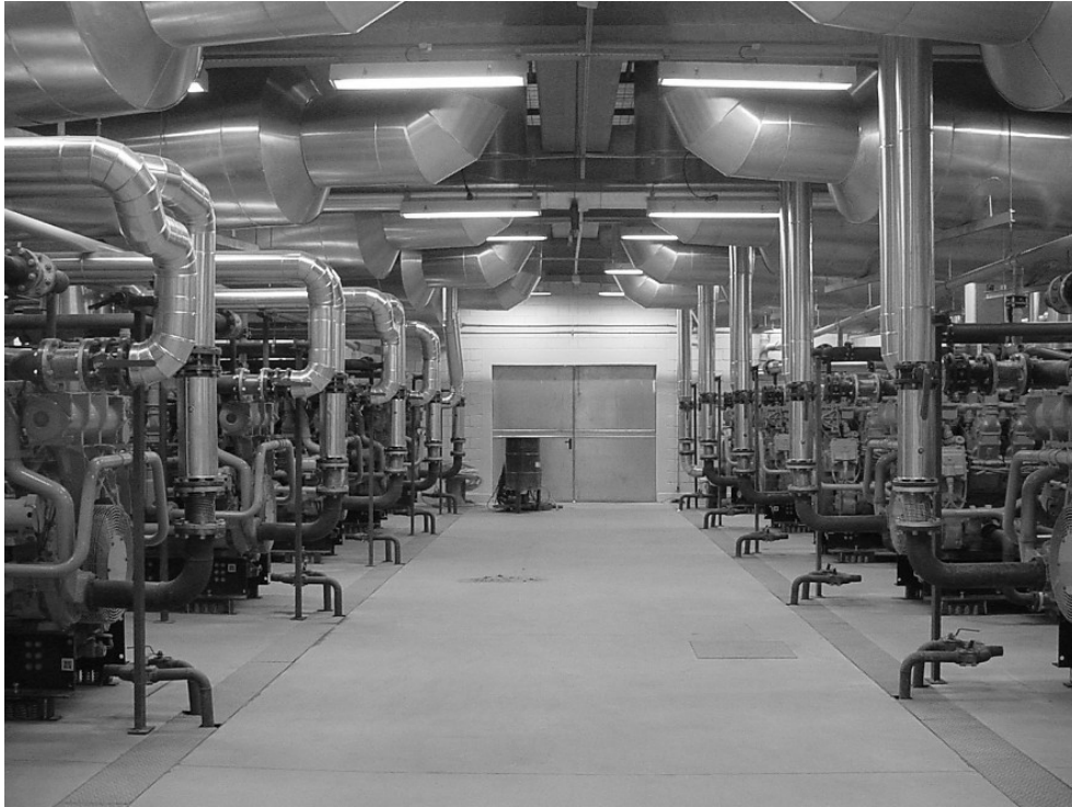
Figura 42: Motores responsáveis pela produção de energia proveniente do biogás, empresa BIOGAS, aterro Bandeirantes, São Paulo - SP.
