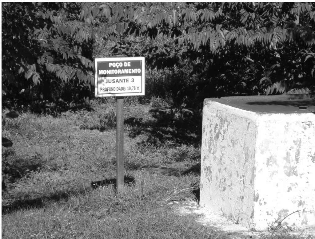
Figura 47: Poço de monitoramento de água subterrânea a jusante, aterro sanitário de Uberlândia.
