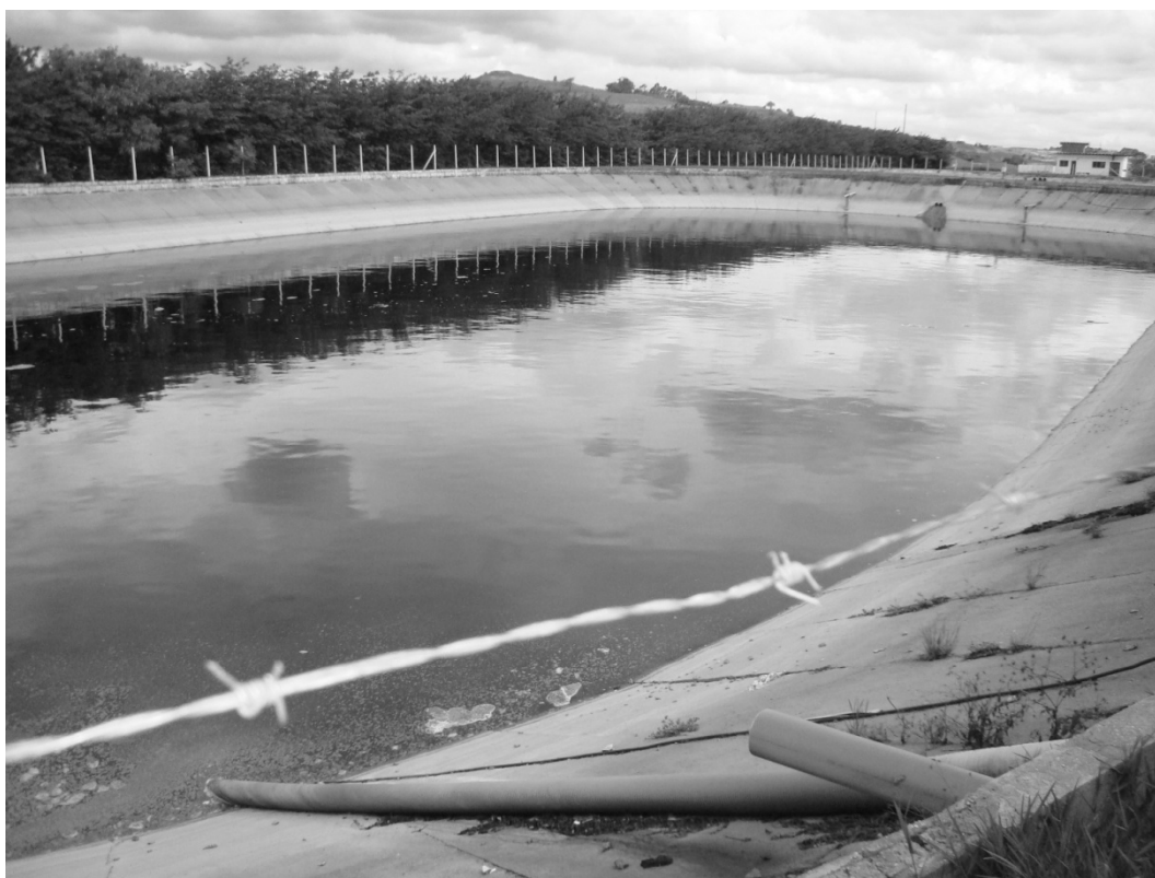
Figura 40: Lagoa de armazenamento de chorume, aterro Bandeirantes, São Paulo – SP. Fonte: A autora, 2009.
