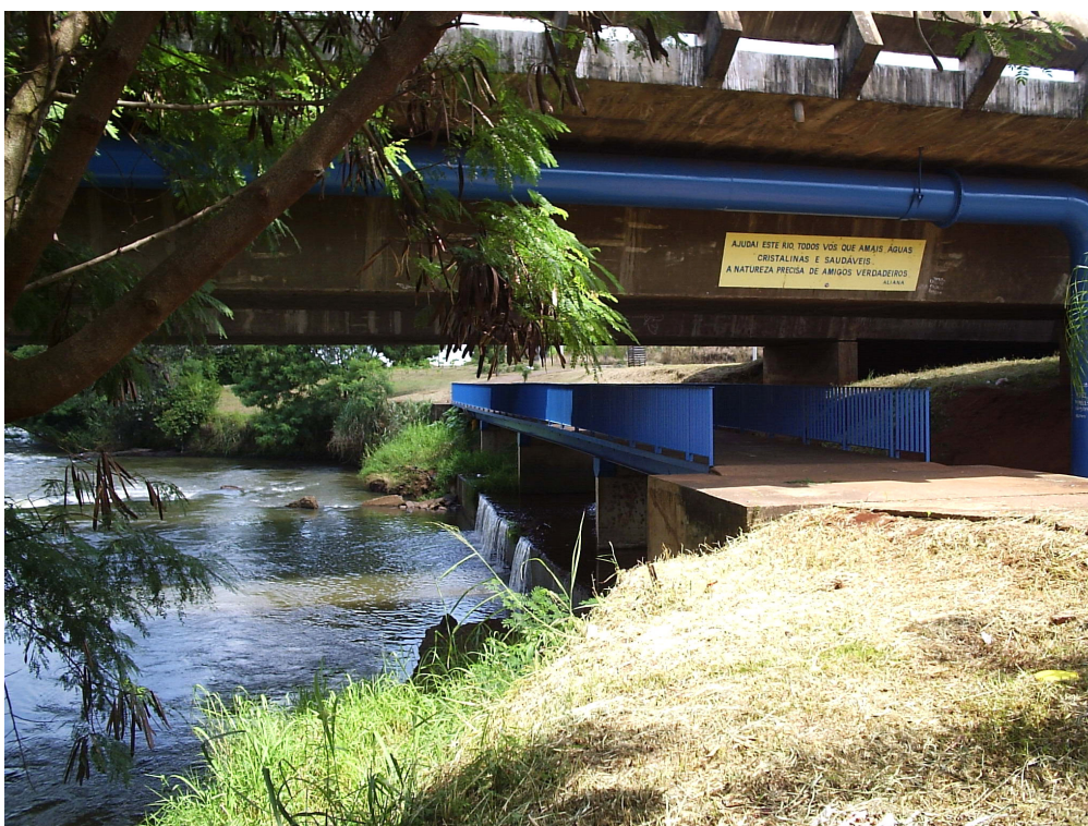
Figura 4.1 – Vista do rio Uberabinha no local denominado Ponte da Av. Getúlio Vargas
