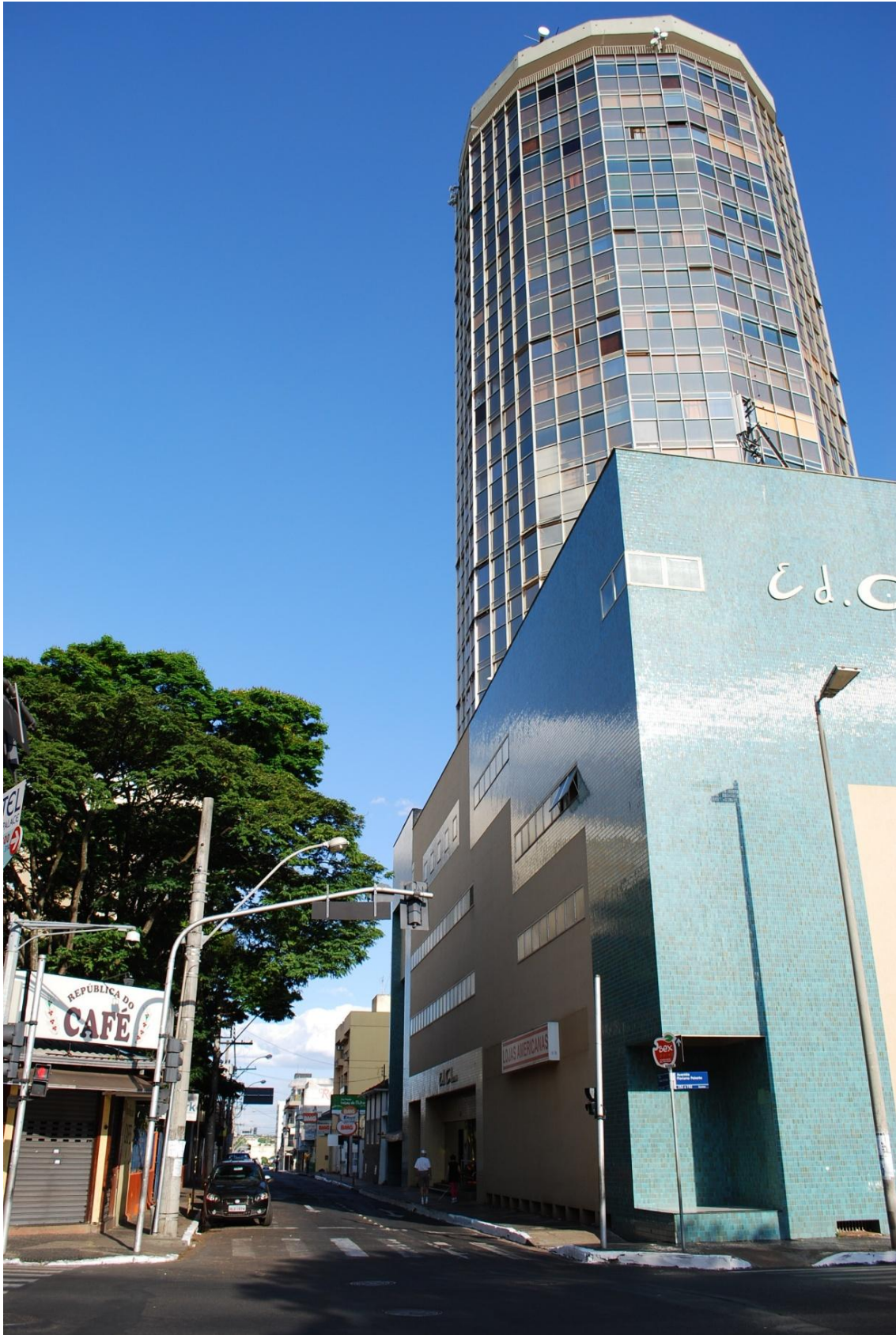
FIGURA 01 – Edifício Chams – Uberlândia (MG).
