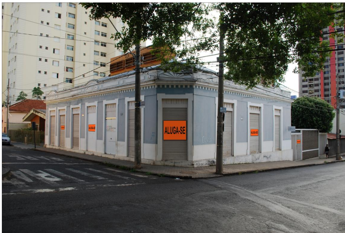
FIGURA 38 – Edifício Chams – Uberlândia (MG).
