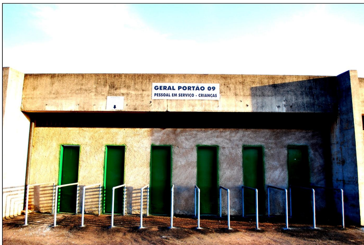
FIGURA 31 – Portão 09 do Estádio “Parque do Sabiá” – Uberlândia (MG)
