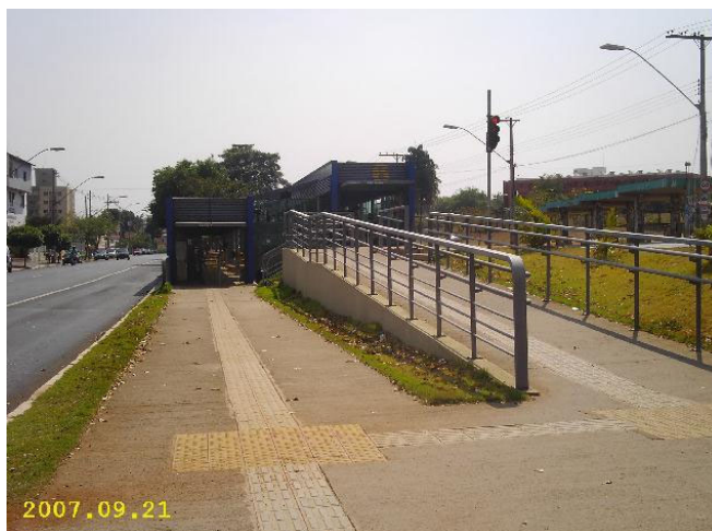
Figura 14 – Rota acessível à estação 6 do corredor da Av. João Naves de Ávila – Uberlândia, MG – 2007
