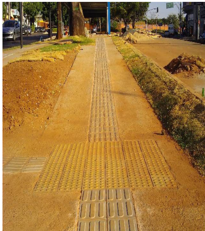
Figura 4 – Calçada em execução no Corredor da Av. João Naves de Ávila – Uberlândia, MG – 2006
