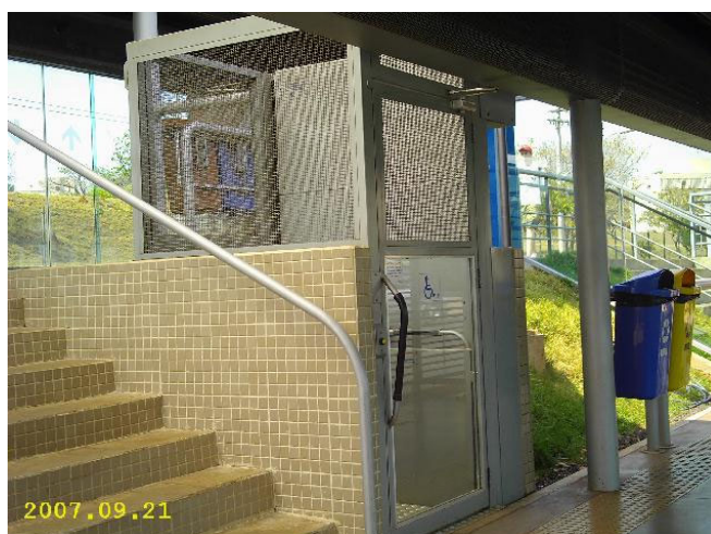
Figura 13 – Elevador para PCD – estação 6 do corredor da Av. João Naves de Ávila – Uberlândia, MG – 2007
