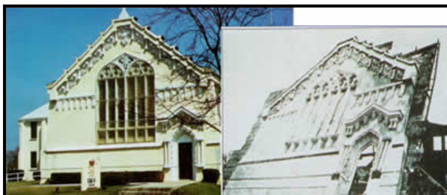
Figura 2.2 – Frontal da Igreja Metodista de Zion, Illinois – USA – 1908.
