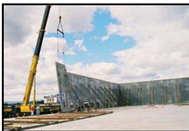
Figura 2.3 – Levantamento de um painel de parede pelo processo tilt-up .
