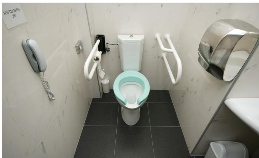
Fig. 10: Banheiro adaptado para deficientes.
