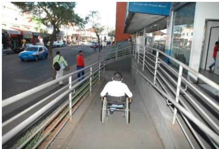
Fig. 4: Rampa de acesso para deficientes Fonte: http://www.mobfloripa.com.br/
