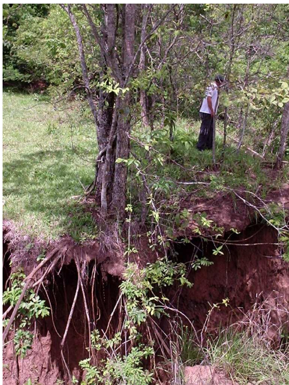
Figura 12: Processo erosivo ativo, onde se observa uma árvore em vias de ser tragada pela erosão. Atentar para o solapamento do talude de erosão - seção 1/ Estação Boa Vista. Autor: VIEIRA, W.C. – dez/2004.
