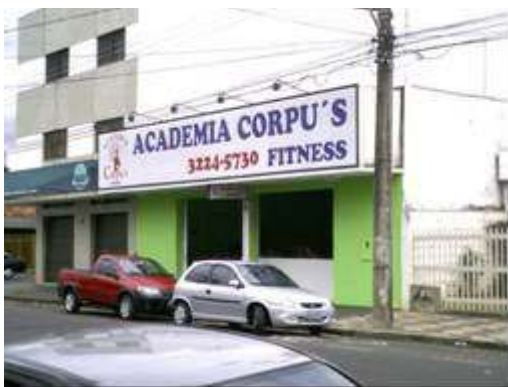
Figura 8.1 – Marquise com sobrecarga por painel Publicitário – Marquise 22U
