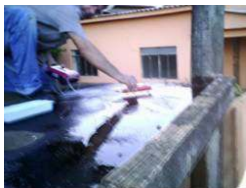
Figura 7.10 – Realização de ensaio de resistividade Elétrica em Marquises.
