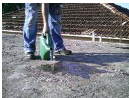
Figura 7.7 – Umedecimento da Superfície da marquise para ensaio de potencial de corrosão.
