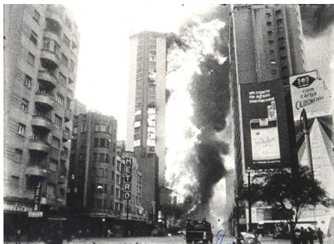
Figura 6: Incêndio no edifício Andraus
