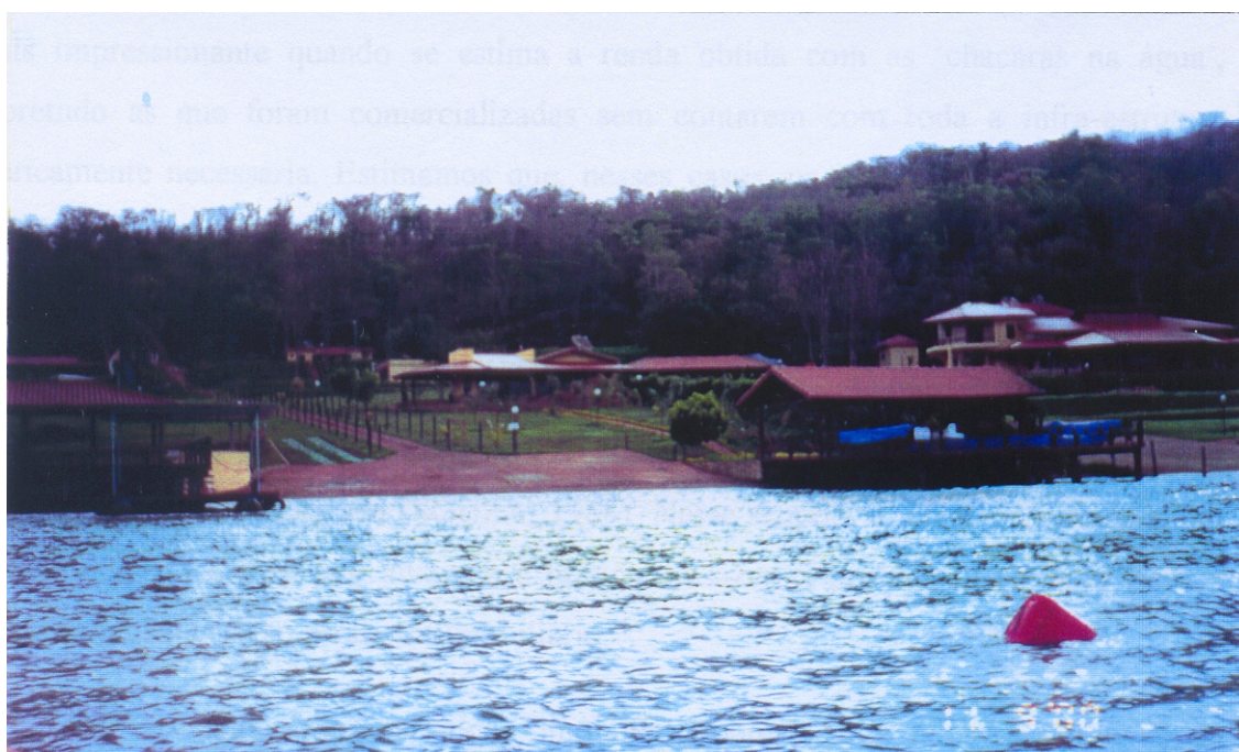
FIGURA 41 - Chácaras à margem da água do lago da UHE de Miranda, ocupando a área destinada à APP por legislação, além de ter o nível d'água (cota 696 m) como um de seus limites.
