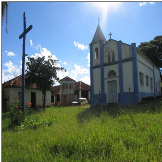
FIGURA 37 - Capela São Sebastião do Fundão – AHE Capim Branco II, margem Araguari. Fonte: PLANO DIRETOR - AHEs CAPIM BRANCO I e II (2005, p. 59). Org.: SILVA, F. B., 2007.
