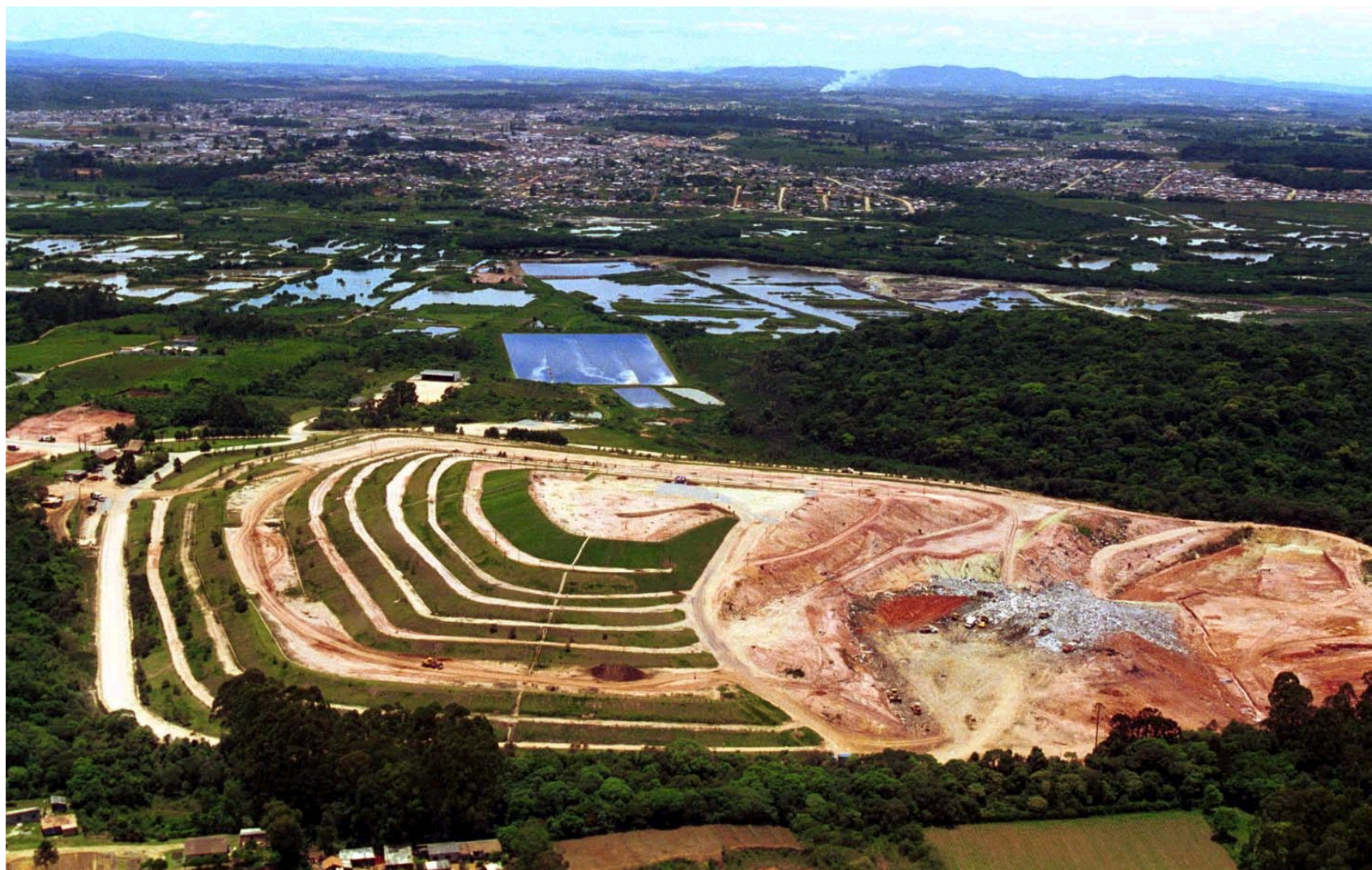
Figura 04: Aterro Sanitário da Caximba – Curitiba/PR Fonte: www.curitiba.pr.gov.br
