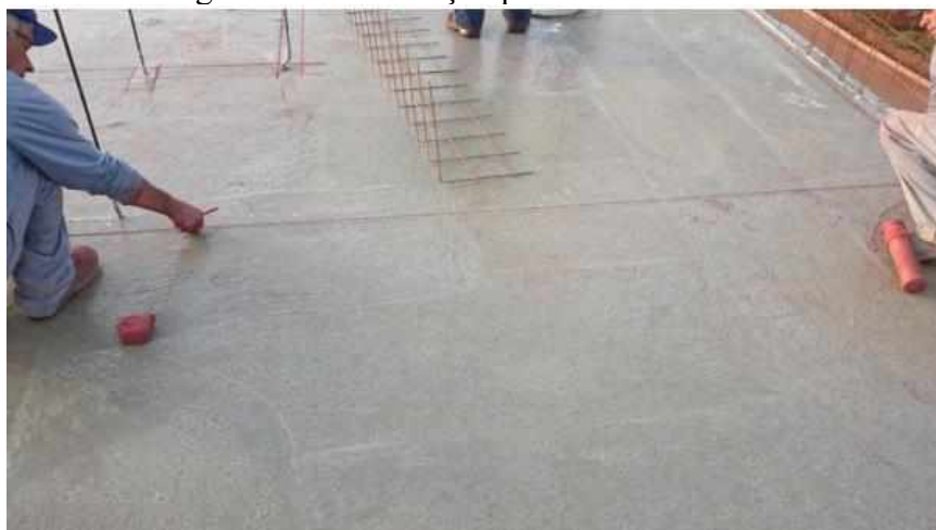
Figura 6 – Demarcação para instalar a fôrma
