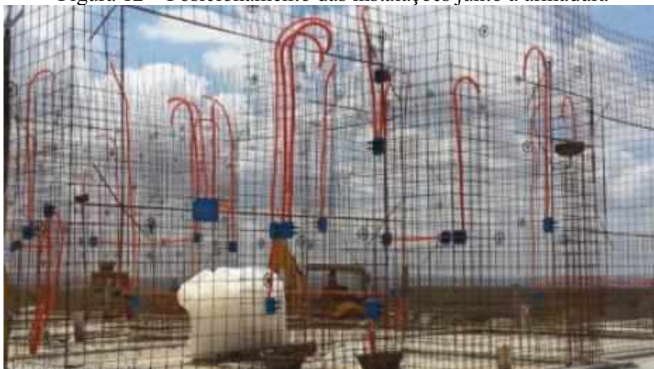
Figura 12 – Posicionamento das instalações junto a armadura
