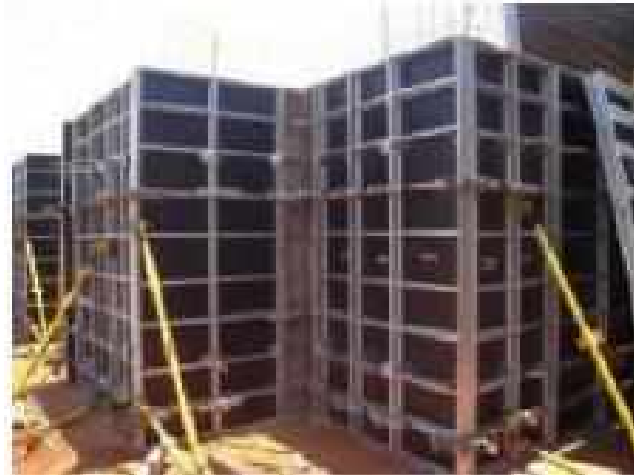
Figura 8 – Fôrma Metálicas com Compensado
