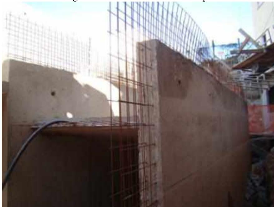
Figura 14 – Armadura com tela dupla
