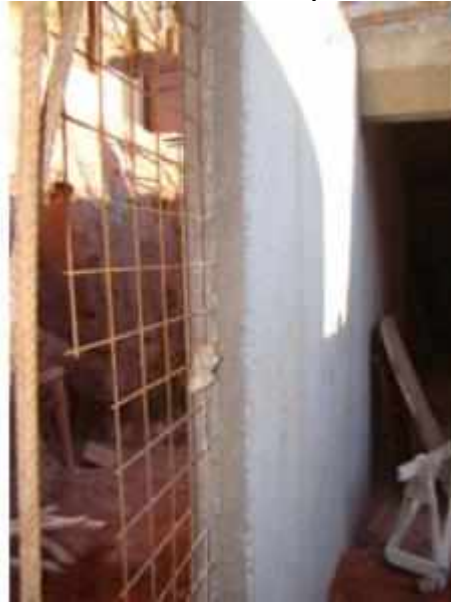
Figura 13 – Armadura com tela simples centrada na parede
