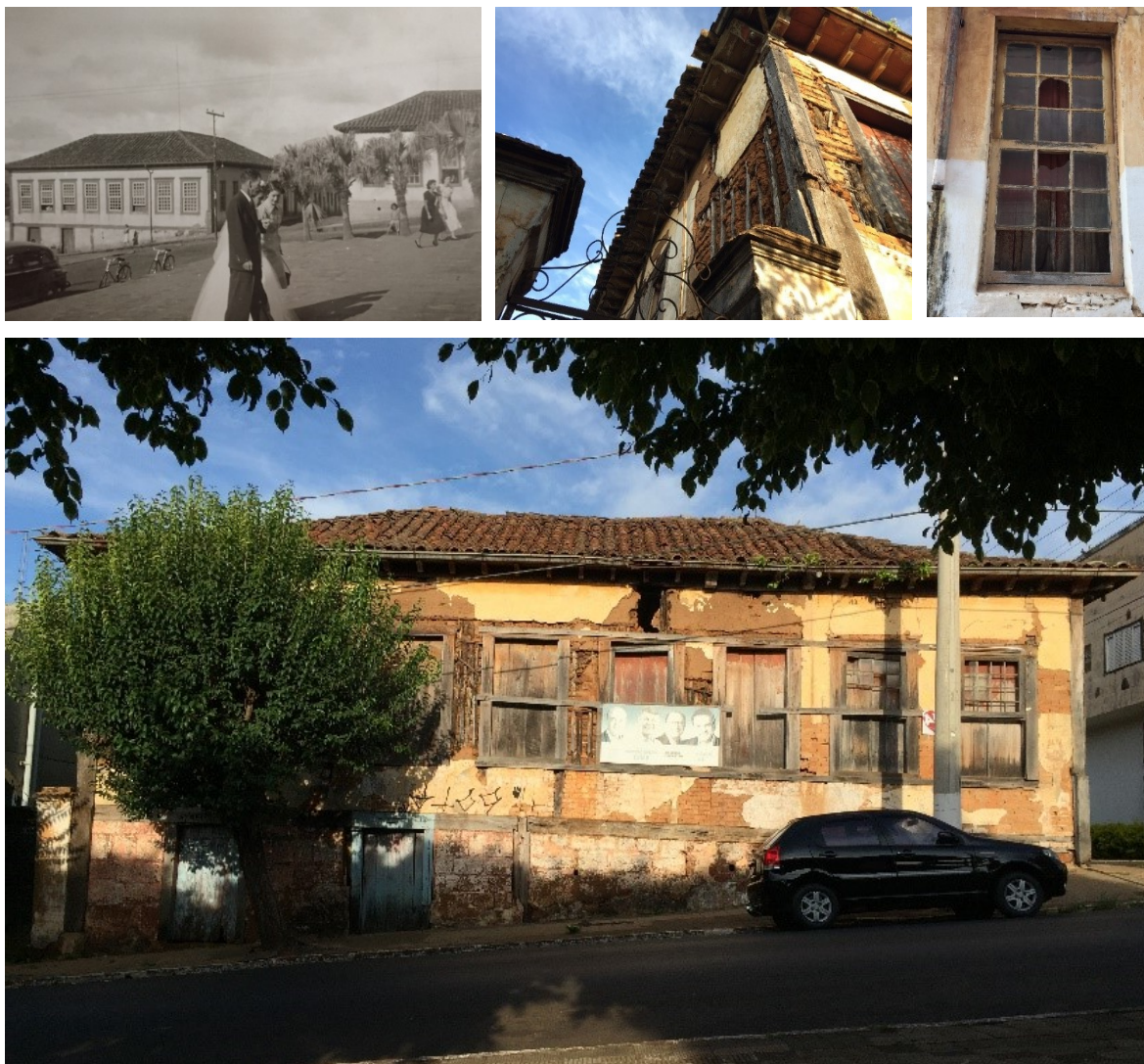
Figuras 04,05, 06 e 07: Construção tradicional (Edificação conhecida como “Casa do Gigot/Gigô”).
