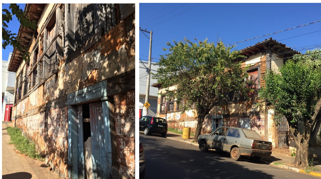
Figuras 109 e 110: Casa do Gigô/ Gigot (edificação degradada)
