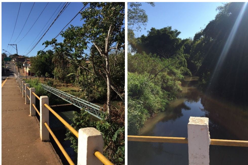
Figuras 90 e 91: Ponte sobre o rio Sapucaizinho na entrada da cidade.
