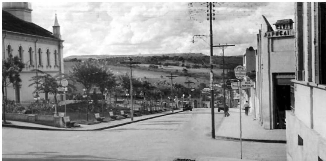
Figura 20: Vista da Rua Cel. Antônio Jacinto, provavelmente antes da década de 1970 (por conta de uma edificação que posteriormente foi demolida).
