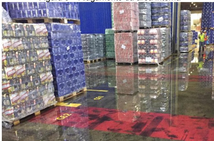
Figura 9 – Alagamento da área interna
