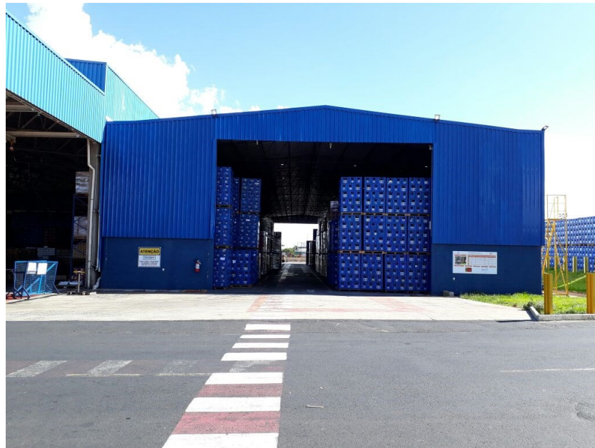
Figura 6 - Galpão de estrutura metálica
