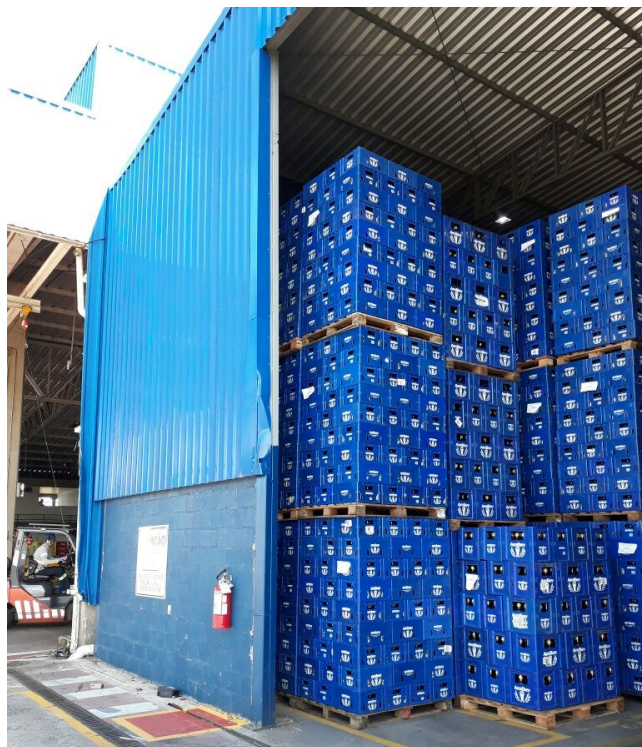
Figura 7 - Galpão de estrutura metálica
