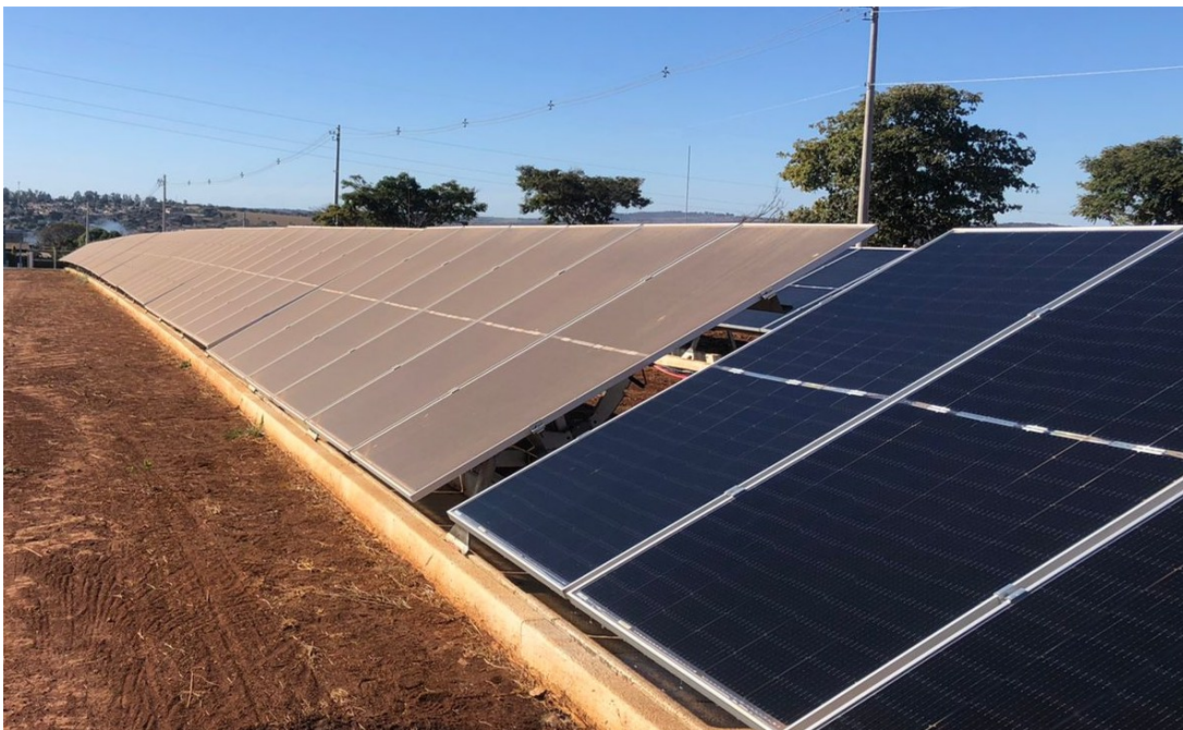
Figura 3 - Diferença entre módulos limpos e sujos.
