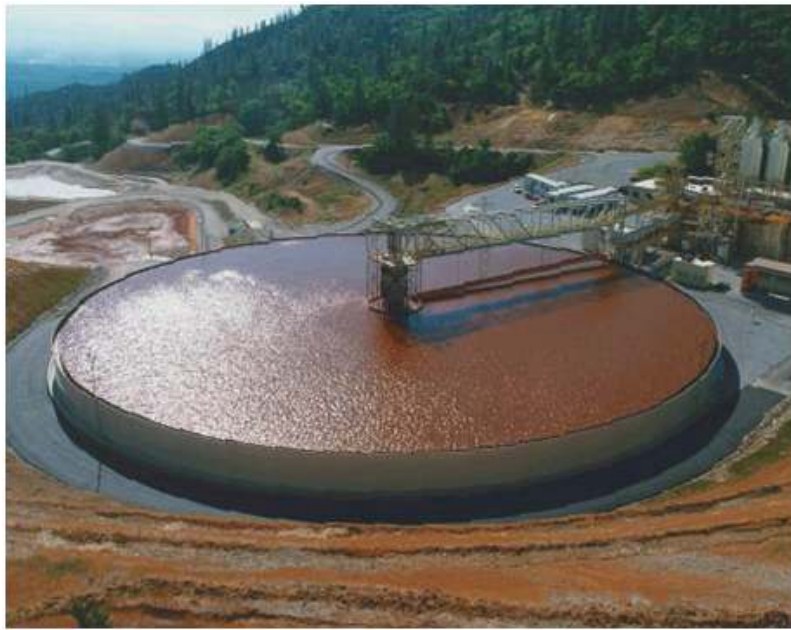
Figura 1.1: Sedimentador convencional em operação.
