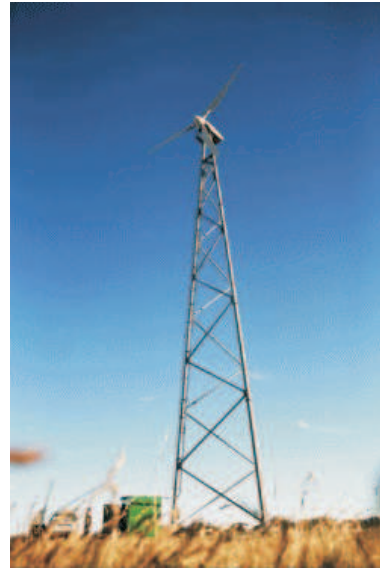
(b) Torre treliçada.
