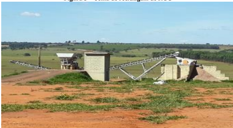
Figura 3 – Usina de reciclagem de RCC
