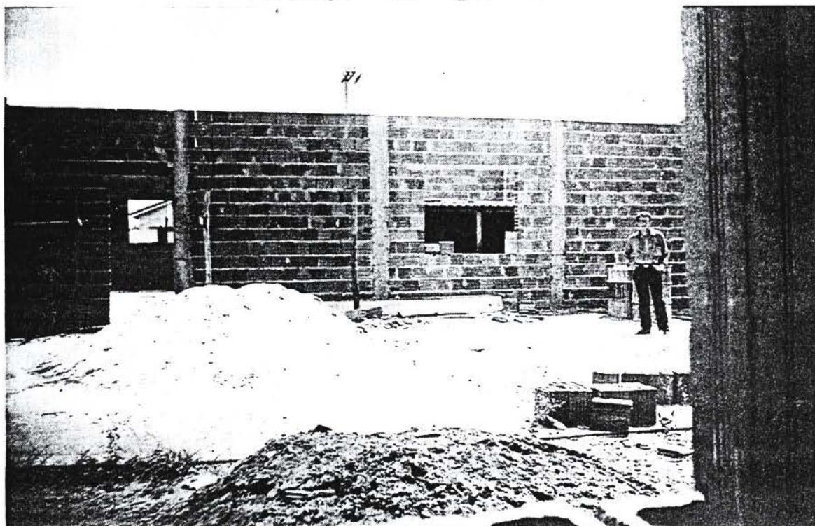
Obras de ampliação da sede social da ANUDI, no Bairro Pacaembu.
