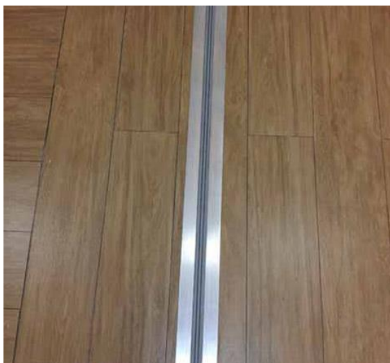
Figura 11- Modelo Perfil FWFC-100 (Sobrepor) - para Junta de Encontro – JE
