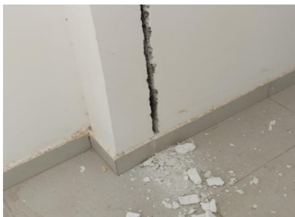
Figura 15 – Limpeza da Junta de dilatação
