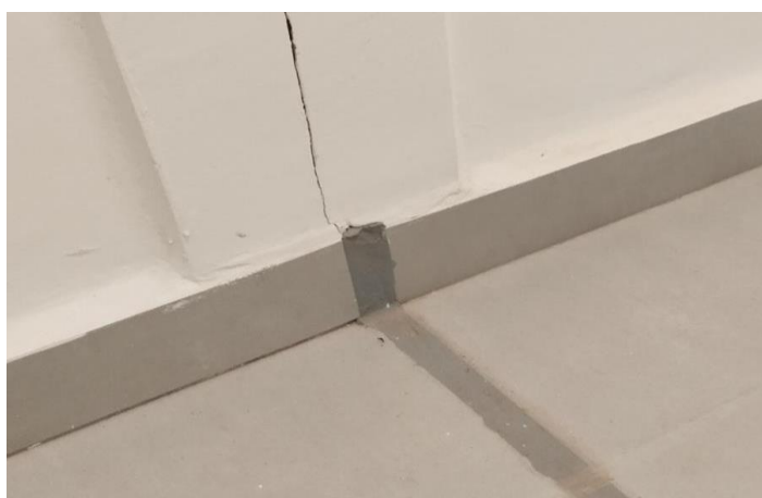
Figura 16 – Preenchimento da Junta com Mastique PU 40
