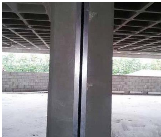
Figura 12 - Modelo de Perfil GFS-100 (embutir – sobrepor) para Junta de Dilatação - JD
