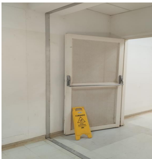
Figura 18 – Acabamento em junta de Dilatação (Mata Piso)
