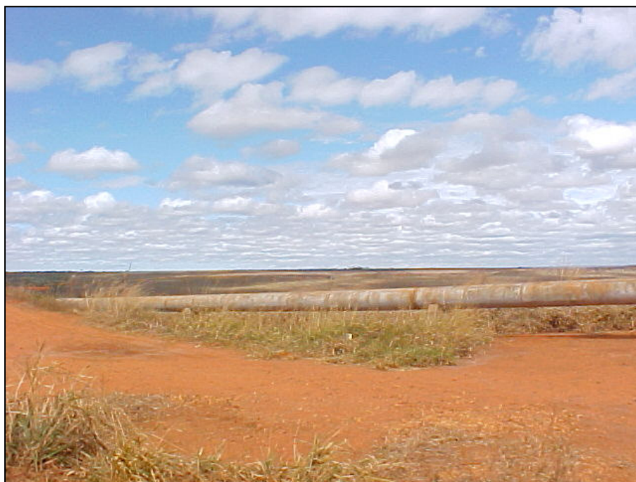
FIGURA 14- Tubulação que envia a água para a bacia de captação/distribuição.
