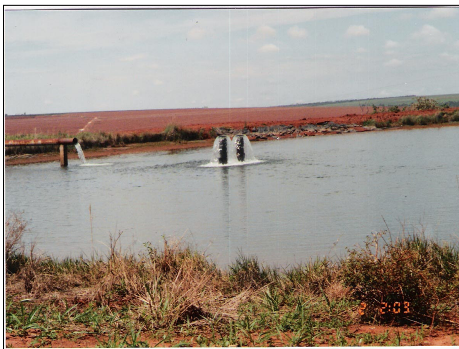
FIGURA 15- Bacia de captação/distribuição para abastecimento dos pivôs centrais.
