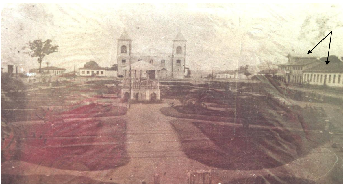
Foto 4: Igreja N. Sra. do Patrocínio, no Largo da Matriz, ao lado, o prédio destinado à fundação do Colégio Normal e o antigo Grupo Escolar Honorato Borges, doado para a instalação do Colégio. Acervo: Colégio Normal N. Sra. do Patrocínio
