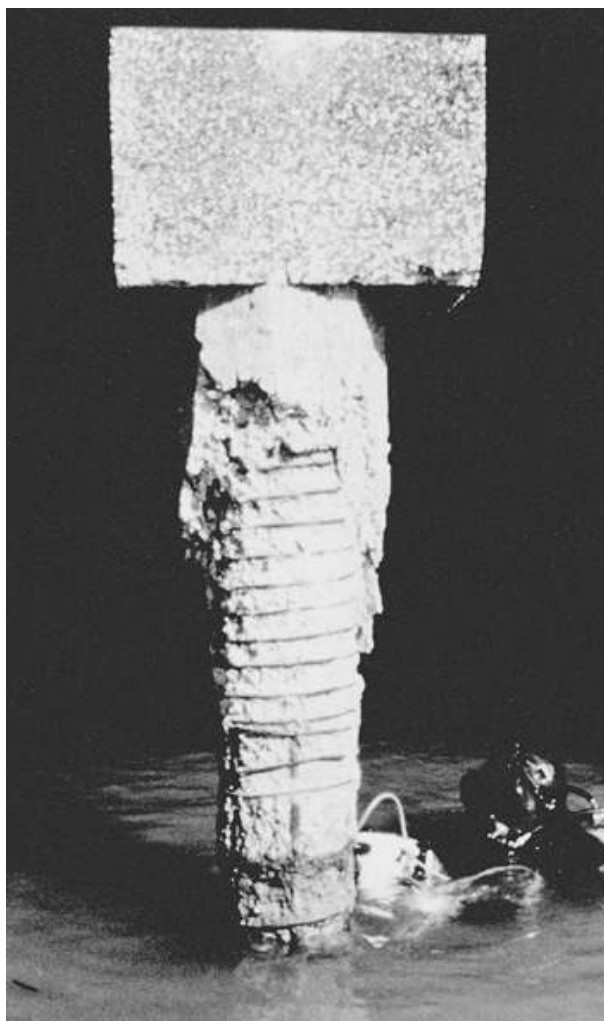
Figura 3.1 - Pilar exposto à mares (fonte: ACI Guide 546)
