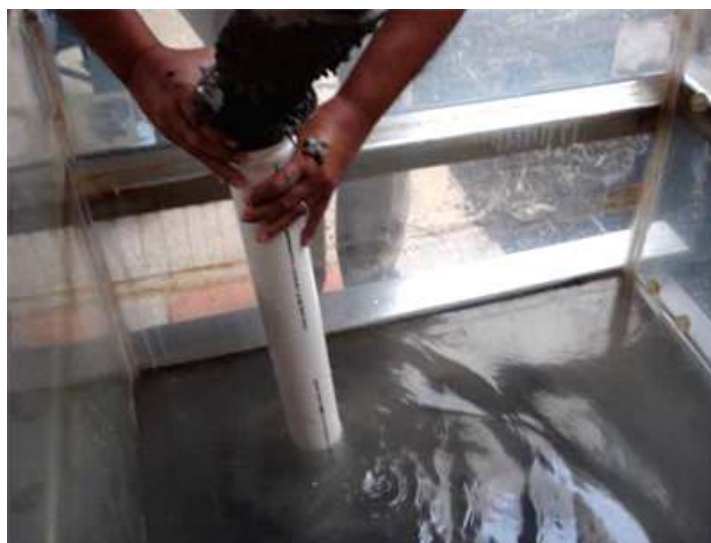
Figura 4.11 - Lançamento do concreto com tubo de 75 mm
