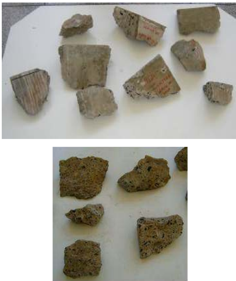
Figura 4.3 - Amostras de concretos extraídas da UHE Itumbiara.
