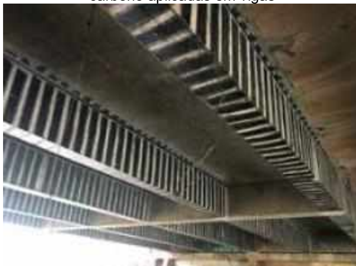
Figura 13 – Compósito de fibras de carbono aplicadas em vigas
