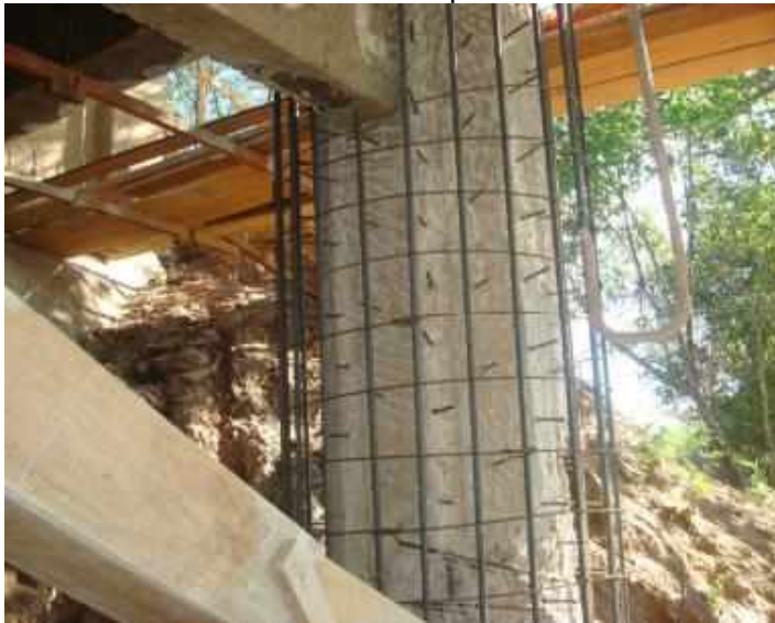
Figura 10 – Encamisamento de um pilar com armadura passiva
