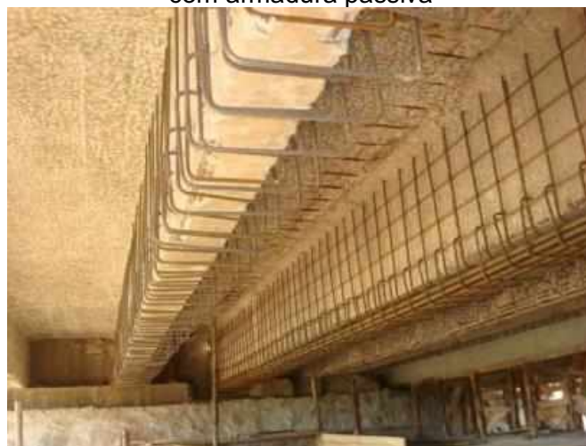
Figura 9 – Encamisamento de uma viga com armadura passiva
