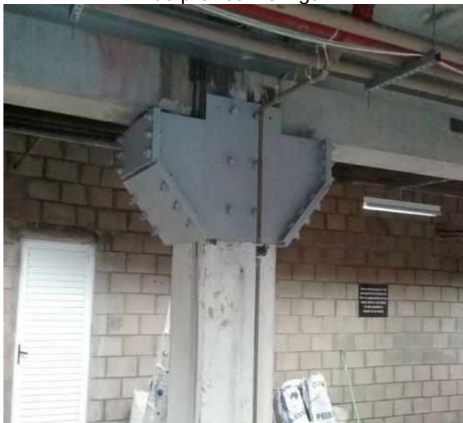
Figura 12 – Perfis metálicos no encontro do pilar com a viga
