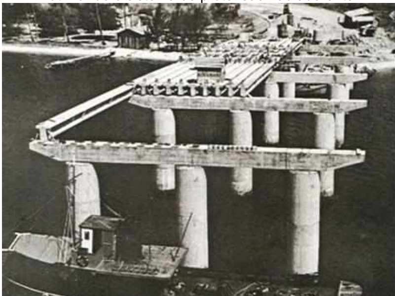
Figura 15 – Construção da Ponte do Galeão, no Rio de Janeiro, utilizando o sistema de protensão não aderente
