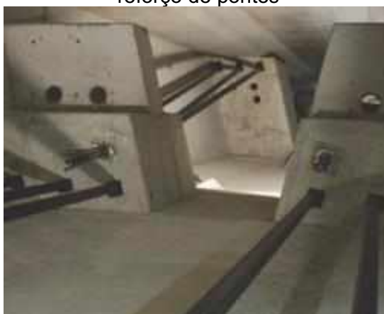
Figura 16 – Protensão externa para reforço de pontes
