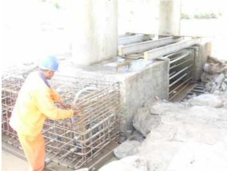
Figura 14 – Vinculação de novas estacas à fundação da obra
