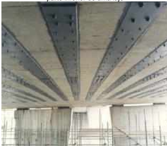
Figura 11 – Chapas metálicas colocadas na parte inferior de uma laje
