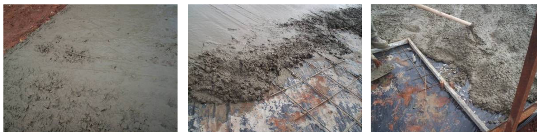
Figura 5.6 – Radier empresa A – Ferragens expostas ou encostadas na lona
