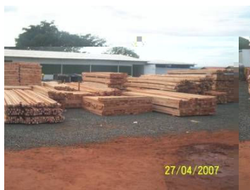
Figura 4.18 – Armazenamento incorreto de madeira de cobertura e esquadria de ferro
