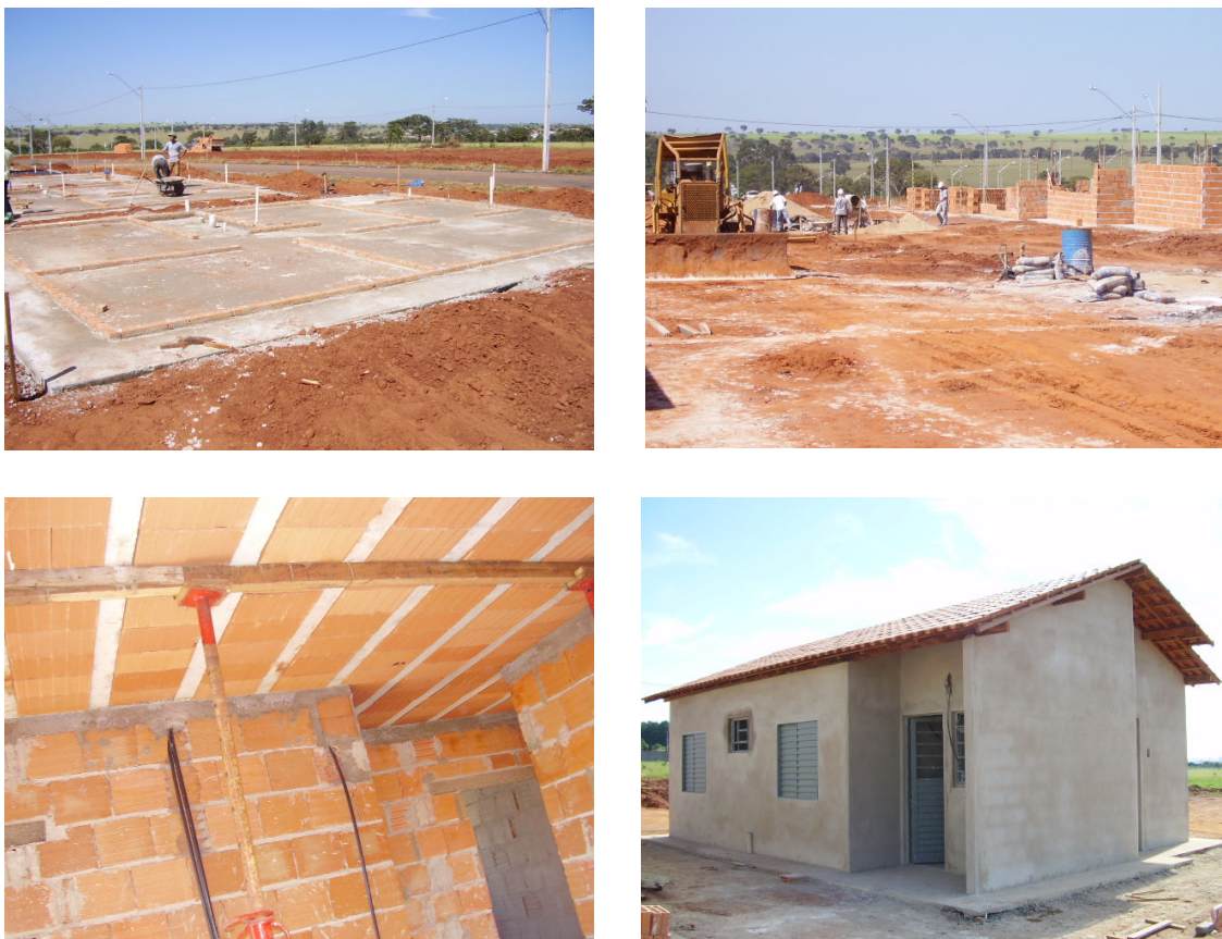
Figura 4.12 – Sistema Construtivo da Empresa D
