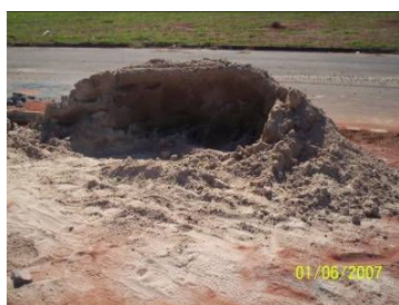
Figura 4.19 – Ausência de baias para os agregados
