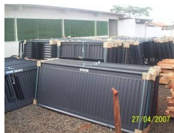
Figura 4.18 – Armazenamento incorreto de madeira de cobertura e esquadria de ferro
