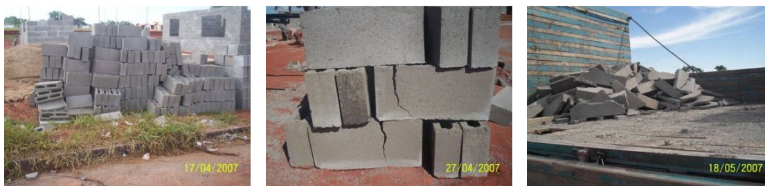
Figura 4.22 – Recebimento e estocagem de blocos de concreto
