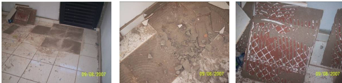
Figura 5.1 – Cerâmicas mal assentadas na empresa A
