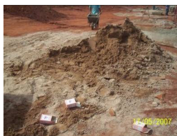
Figura 4.19 – Ausência de baias para os agregados
