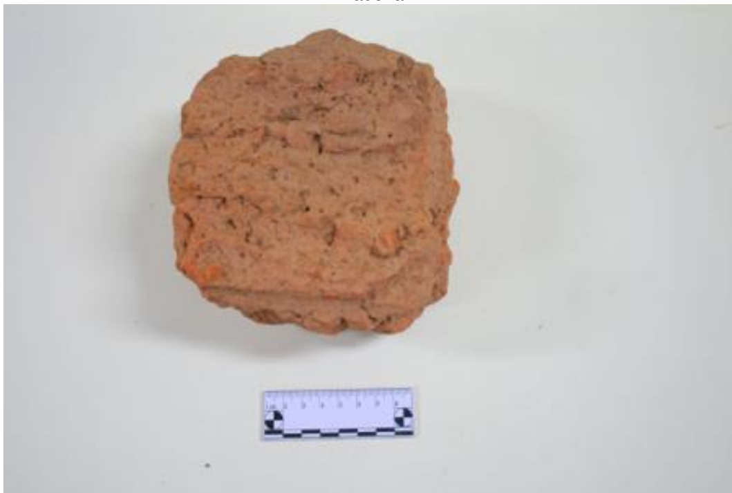
Figura 4 - Blocos de barro provenientes de parede de pau-a-pique com marcas de dedo e de madeira
