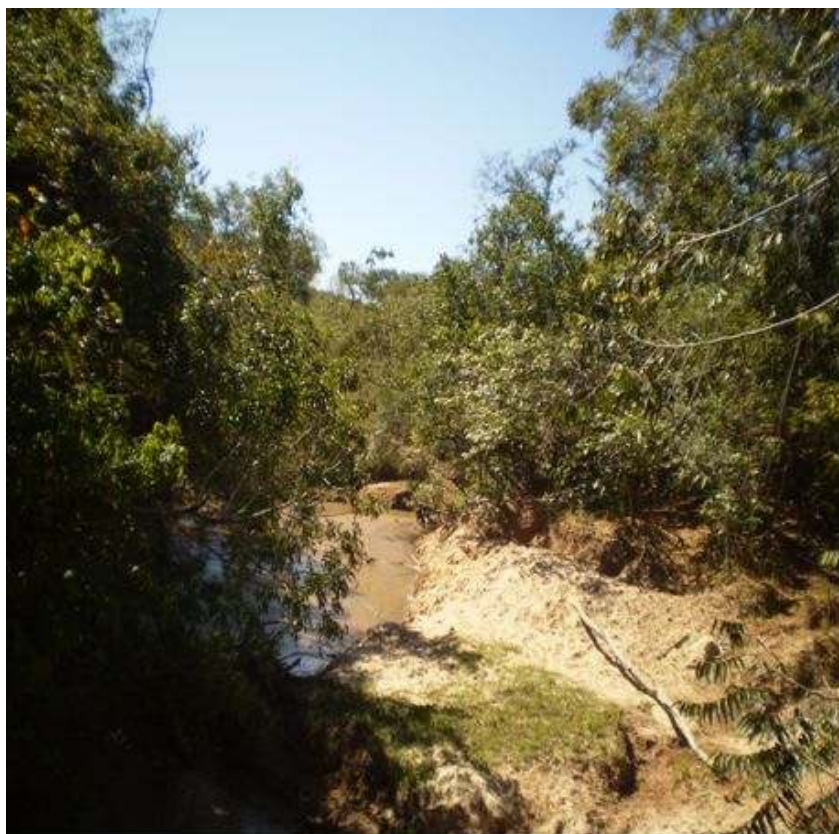
Figura 22. Deposição de grande quantidade de areia no leito do Córrego da Aroeira. Autor: MARTINS, A. P./2008.
