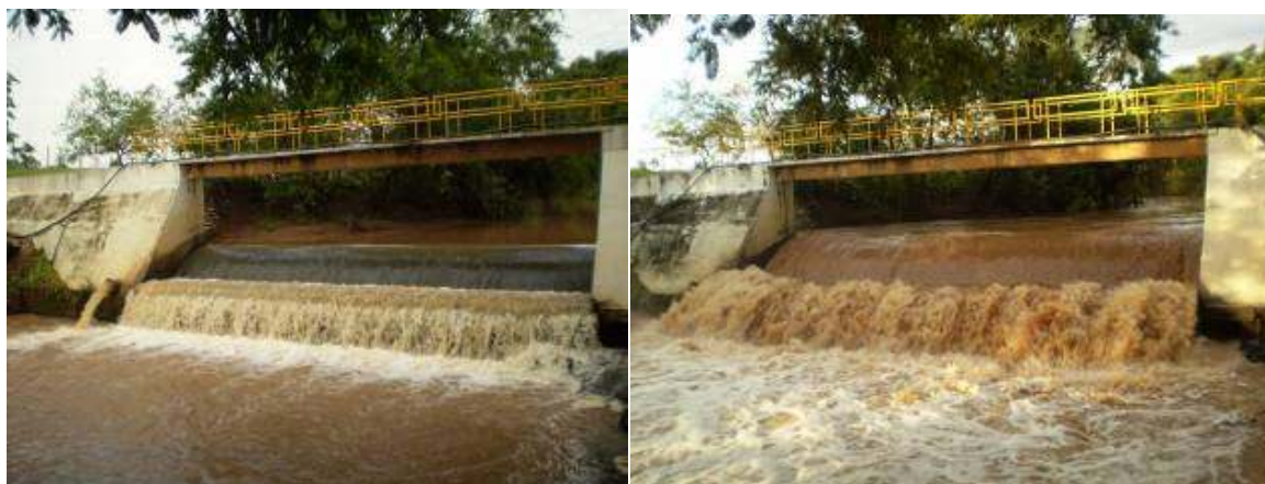
Figuras 59 e 60. Comparação entre o vertedouro da captação de água da COPASA nos meses de dezembro de 2007 (mês chuvoso normal) e no dia 21 de abril, após chuva de mais de 60mm na área das nascentes do Córrego dos Talhados, à mais de 30 Km de distância em linha reta. É interessante observar a turbidez da água, carregada de sedimentos que podem ser provenientes até mesmo das regiões de solo arenoso do alto curso da bacia. Autor: MARTINS, A. P./2007 e 2008.
