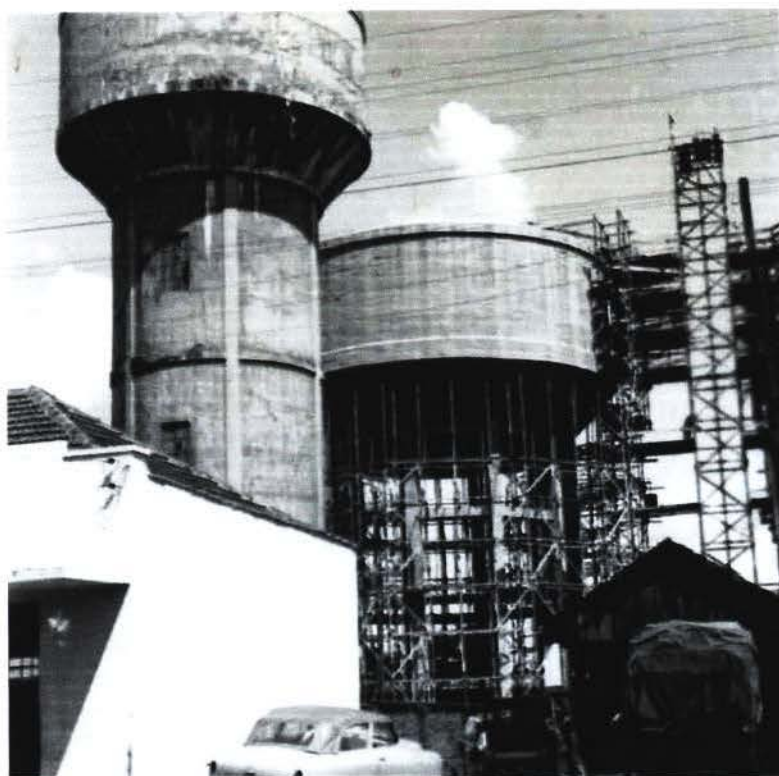
A construção de caixas-d'água na Avenida Floriano Peixoto em 1954. Fonte: CDHIS/UFU
