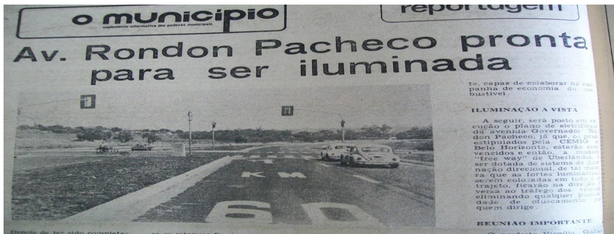
Figura 8 - Imagem da Avenida Rondon Pacheco em fase final de construção. Reprodução de um fragmento do jornal "O Município", Suplemento Informativo dos Poderes Municipais, ano IV, nº 122, Uberlândia 20-08- 1980. Arquivo Público Municipal (anexado ao Jornal "Correio de Uberlândia")
