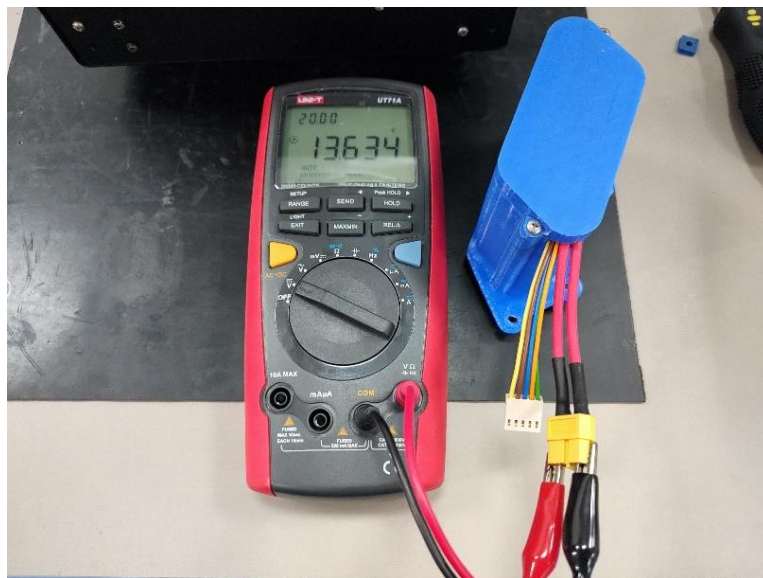
Figura 50 – Nível de tensão do banco de baterias antes do carregamento
