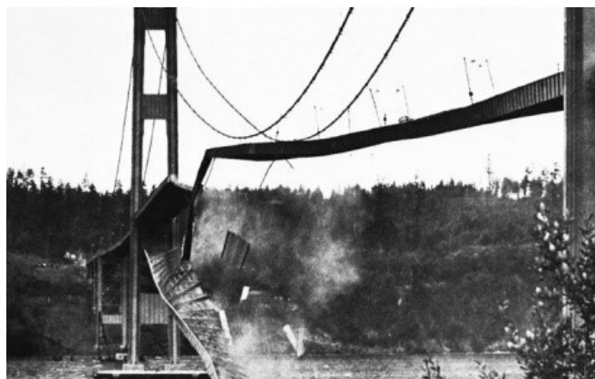
Figura 1.1 – Vibrações induzidas pelo vento sobre a ponte Tacoma Narrows.
