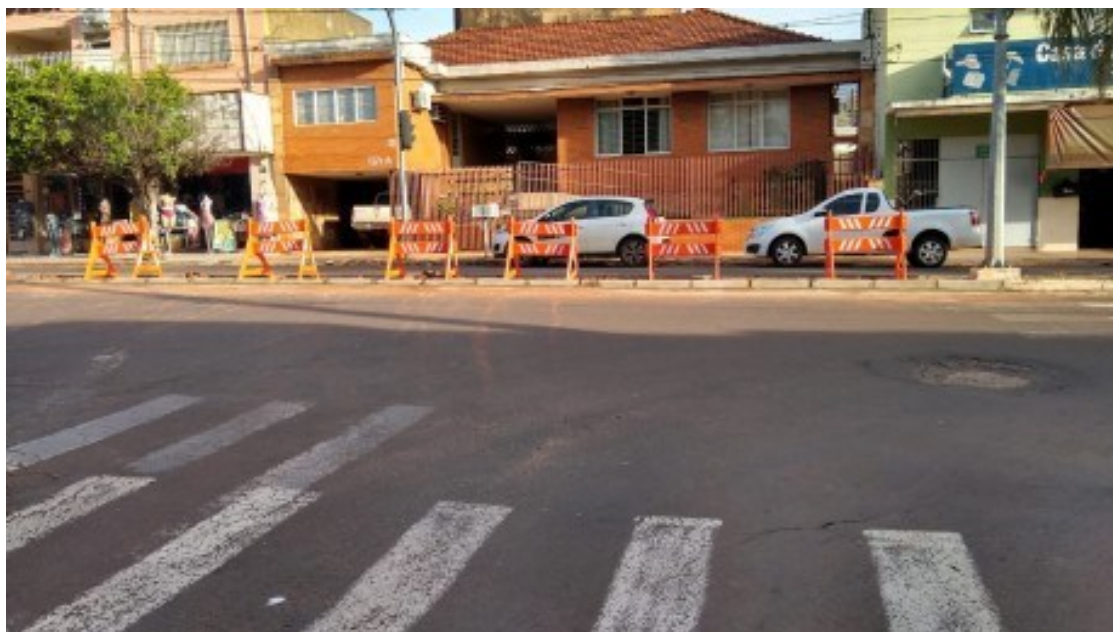
Figura 3 – Obras de fechamento da interseção entre a Avenida Dezesete e a Rua Quatorze
