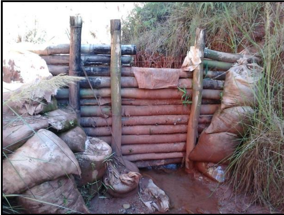
Figura 20 - Barreira rompida pelo fundo. Autor: PEREIRA, 2011.
