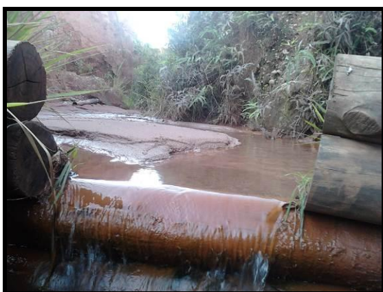
Figura 24 – Barreira B2M repleta de sedimentos. Autor: PEREIRA, 2012.
