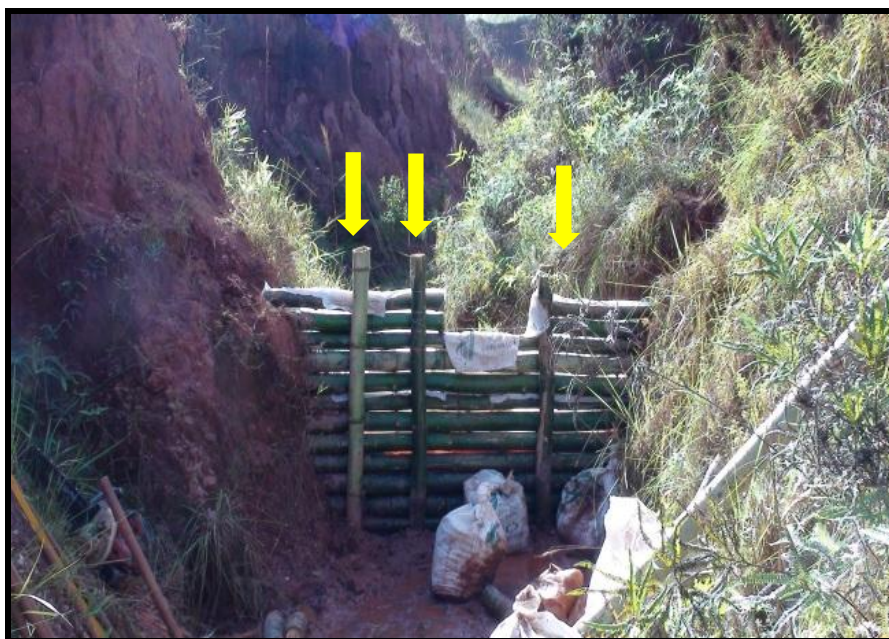
Figura 9 – Barreira B1B construída. Detalhe das escoras de bambu. Autor: PEREIRA, 2011
