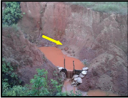
Figura 29 - Deslizamento de talude antes da barreira. Autor: PEREIRA, 2011.
