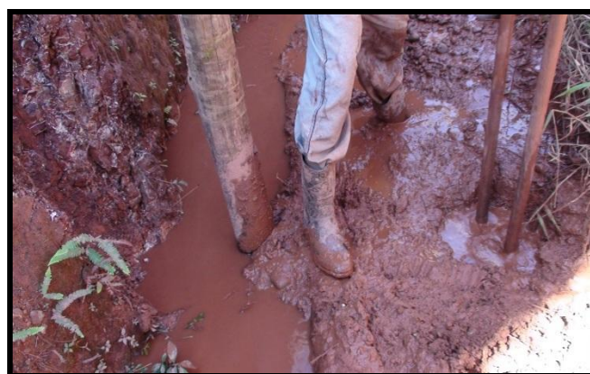
Figura 10 - Buraco feito para colocar a escora de madeira B2B. Autor: PEREIRA, 2011.
