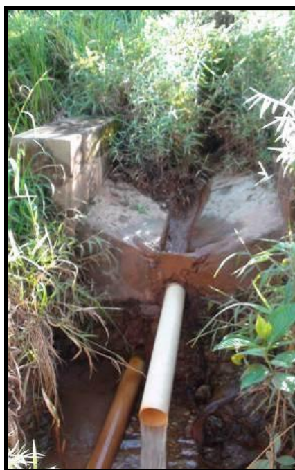
Figura 1 - Vertedouro localizado na Fazenda Experimental do Glória. Autor: PEREIRA, 2011.
