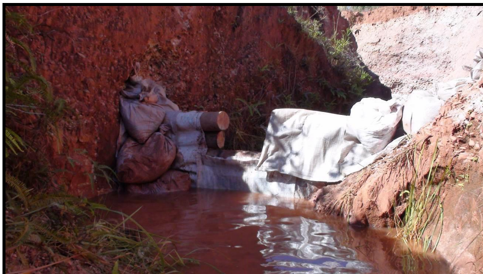
Figura 23 - Local após a construção da barreira B2M. Autor: PEREIRA, 2011.
