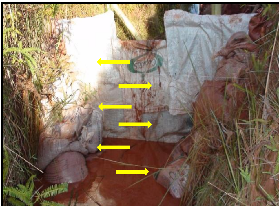
Figura 19 – Barreira B1B construída. Detalhe dos sacos de ráfia cheios de terra. Autor: PEREIRA, 2011.
