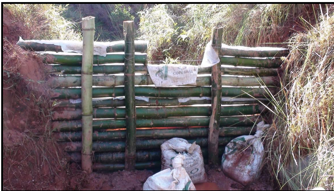
Figura 5 - Vertedouro retangular. Autor: PEREIRA, 2011.
