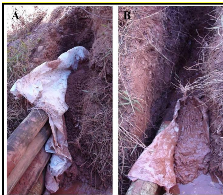
Figura 4 - (A) Sacos de ráfia colocados justapostos firmando o solo entre parede da voçoroca e postes de madeira. (B) Zoom dos sacos de ráfia colocados justapostos firmando o solo entre parede da voçoroca e postes de madeira. Autor: PEREIRA, 2011
