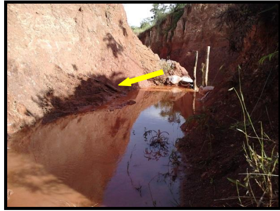
Figura 30 - Deslizamento de talude antes da barreira. Autor: PEREIRA, 2011.
