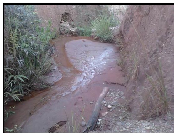
Figura 25 – Barreira B2M repleta de sedimentos. Autor: PEREIRA, 2012.
