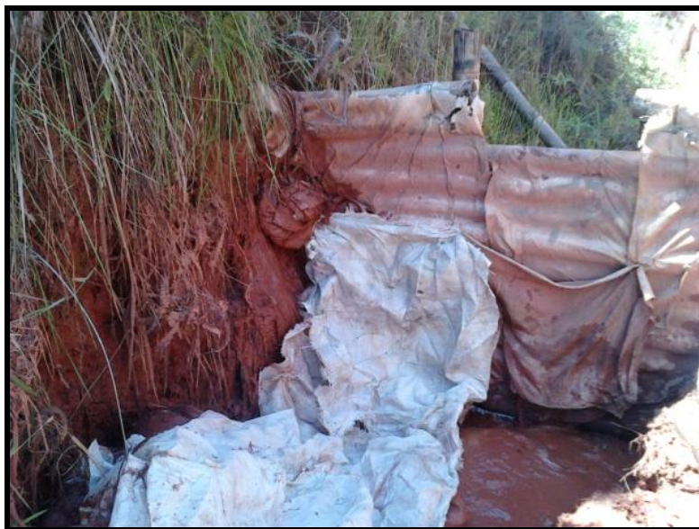
Figura 22 - Reparo da barreira com saco de ráfia aberto. Autor: PEREIRA, 2011.
