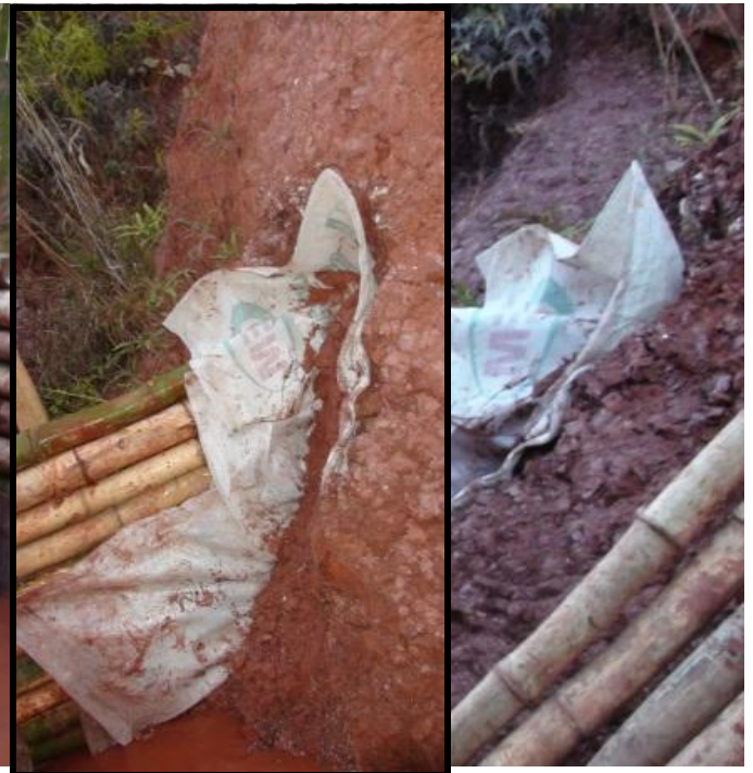
Figura 28 - Detalhe escoras e aterramento das valetas da parede. Autor: PEREIRA, 2011.
