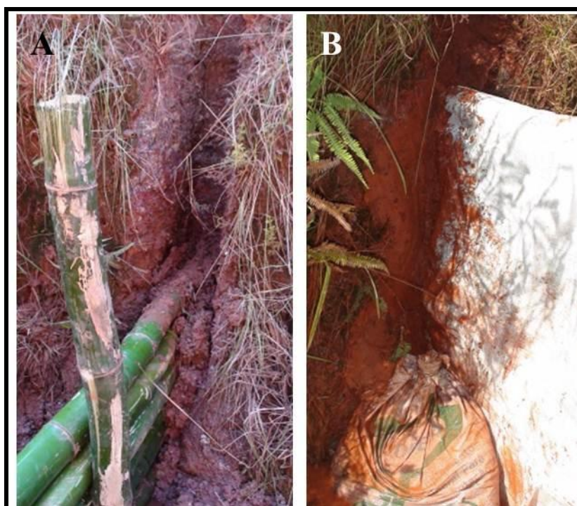
Figura 18 – (A) e (B) Detalhe da valeta na parede da feição erosiva - B1B. Autor: PEREIRA, 2011.
