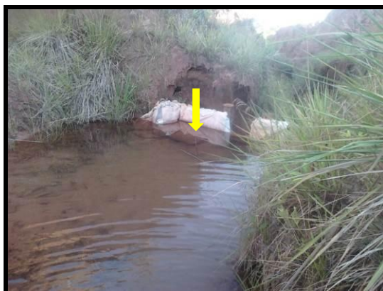
Figura 16 - Vergalhão para monitoramento de sedimento retido antes da barreira. Autor: PEREIRA, 2012.
