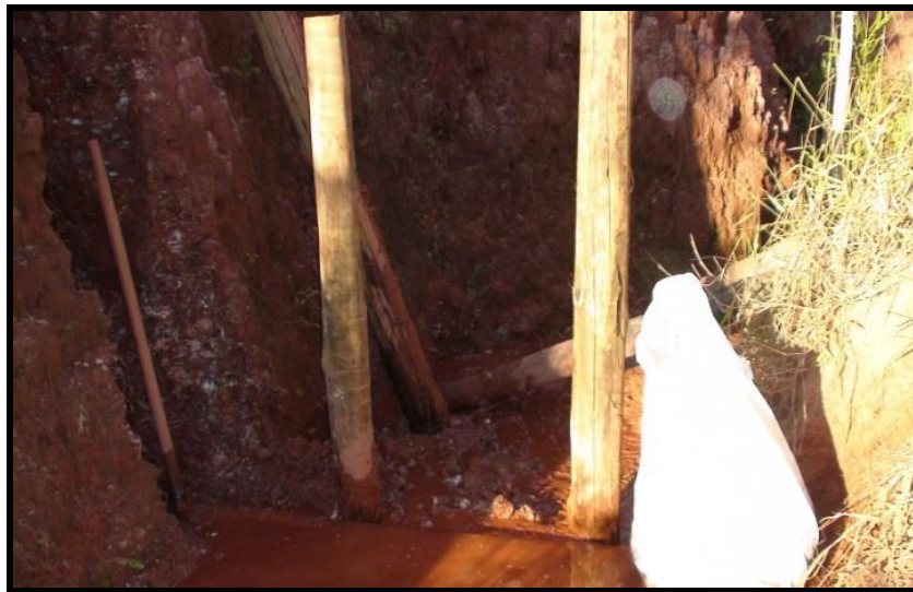
Figura 8 - Construção da barreira B3M. Detalhe dos dois primeiros postes na horizontal. Autor: PEREIRA, 2011
