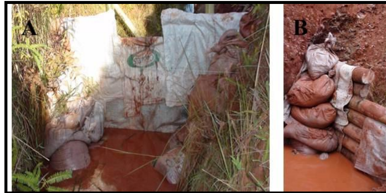
Figura 11 – (A) Barreira B1B construída. Detalhe dos sacos de ráfia cheios de terra. (B) Local após a construção da barreira B2M. Detalhe dos sacos de ráfia. Autor: PEREIRA, 2011.
