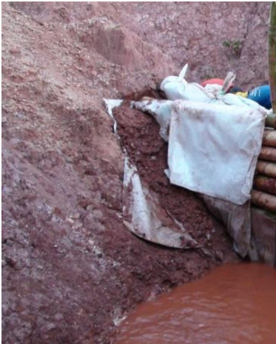
Figura 27 - Construção da barreira B2B. Autor: PEREIRA, 2011.
