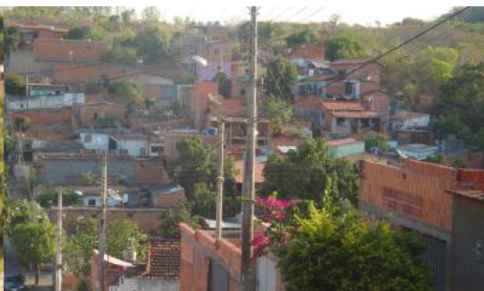
Figura 46 - Novas construções na Favela Nova Morada
