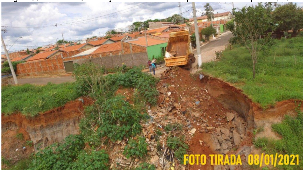
Figura 06: Iturama: RCD's lançados em terreno com processo erosivo aparente, 2021.
