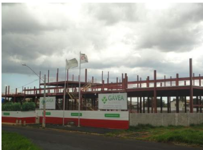
Foto 11 – Vista Externa da Construção do Gávea Business Center
