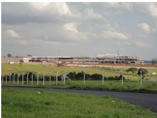
Foto 20 –Vista Externa das Obras de Construção do Uberlândia Shopping – primeiro semestre de 2011
