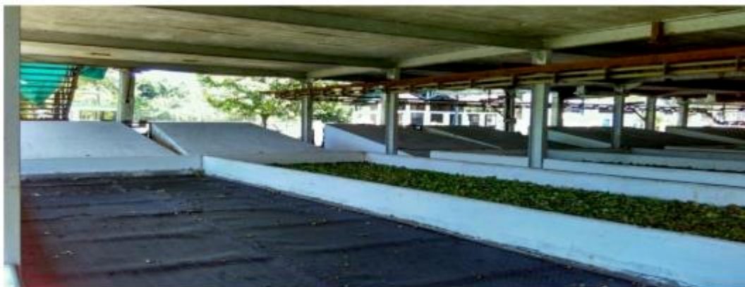
Figura 6 – Estufa aberta para a realização da etapa de murcha.
