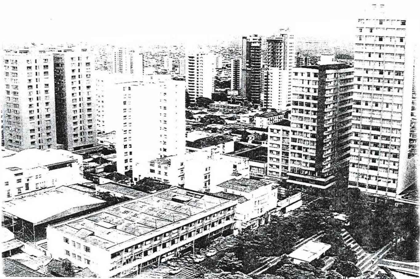
Foto recente. arquivo Municipal de Uberlândia.
